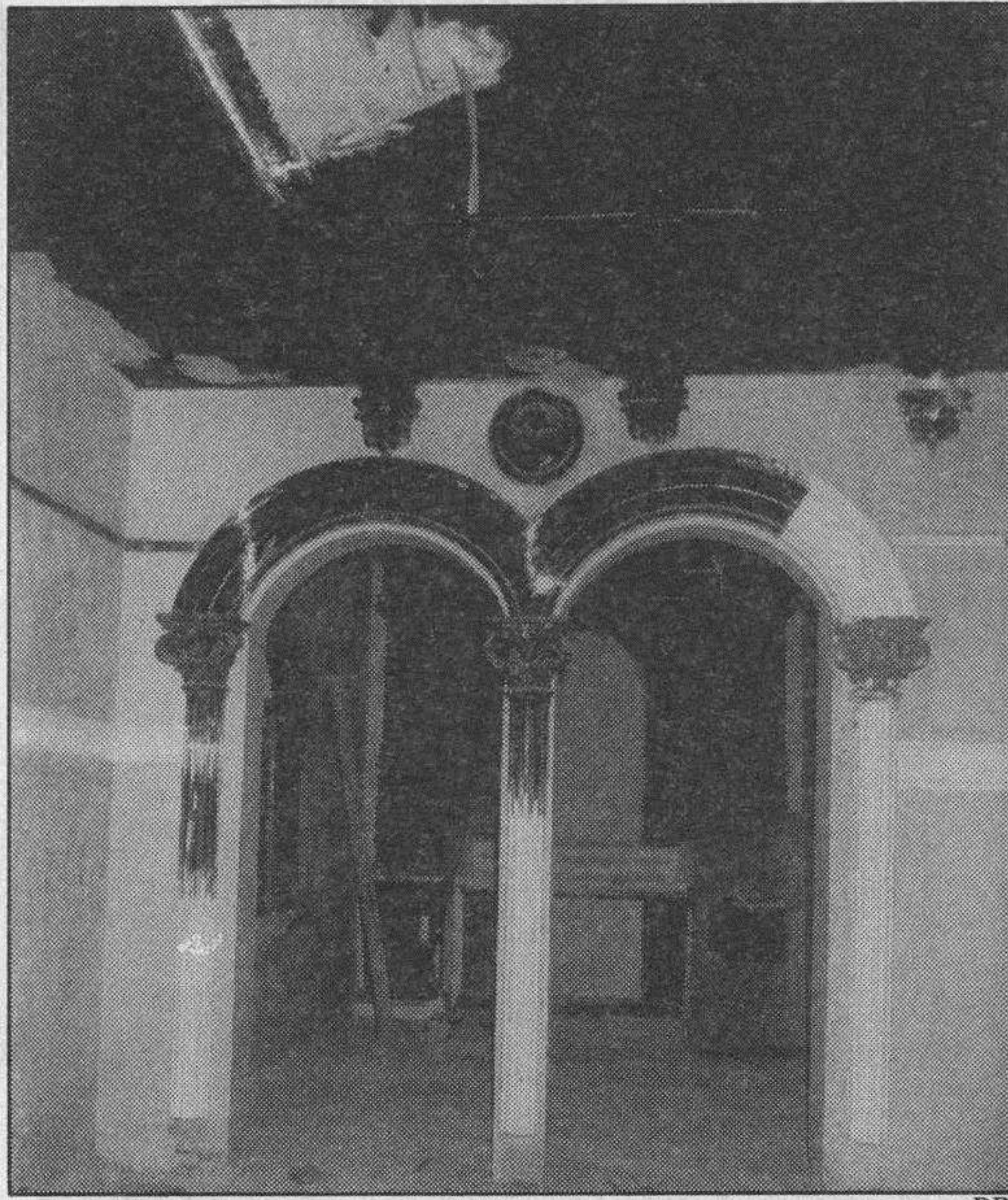
Las actuaciones en Burgos se ciñen a la rehabilitación de edificios.
