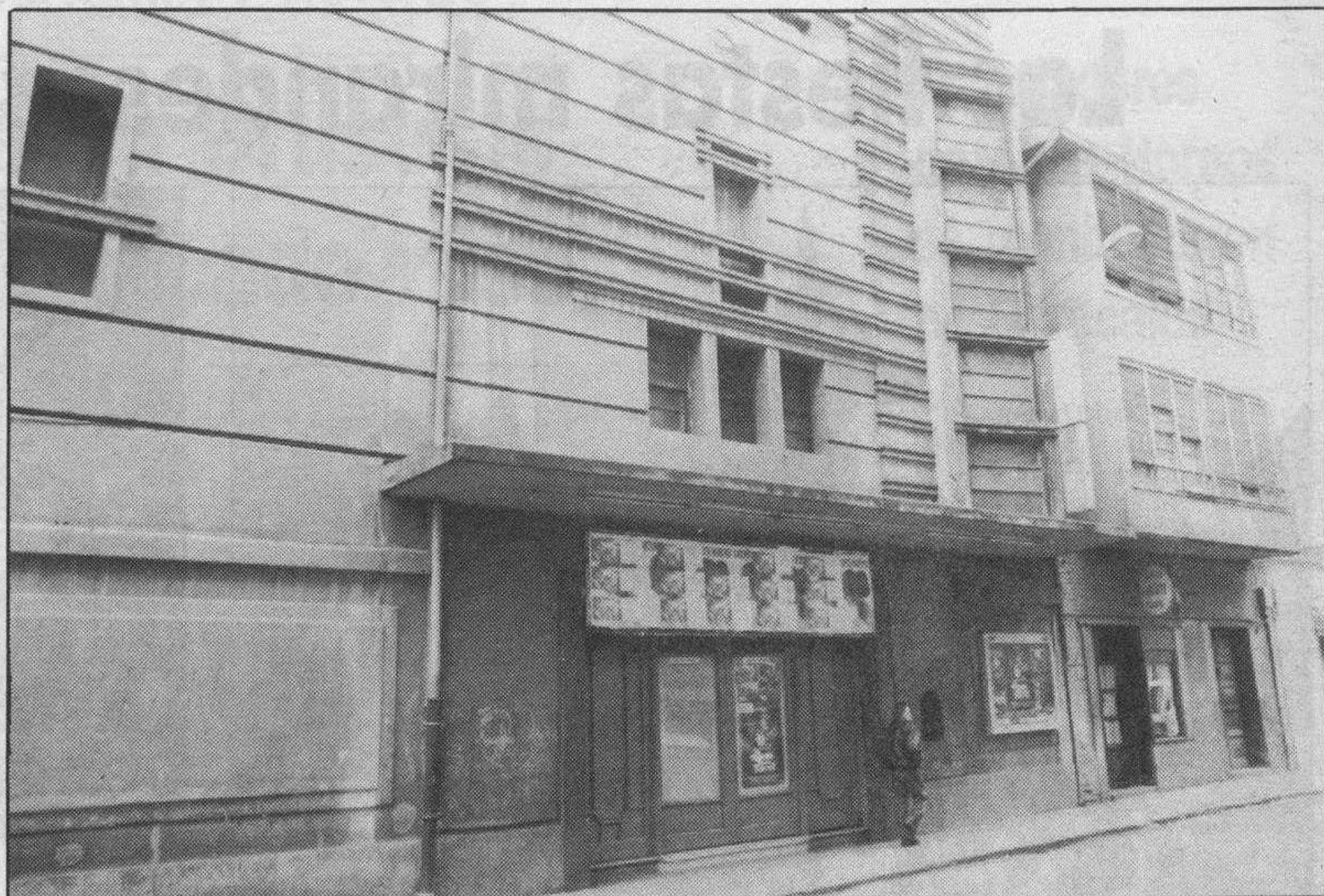
En futuras fechas el edificio desaparecerá para convertirse en viviendas. (Foto: Truchuelo).
