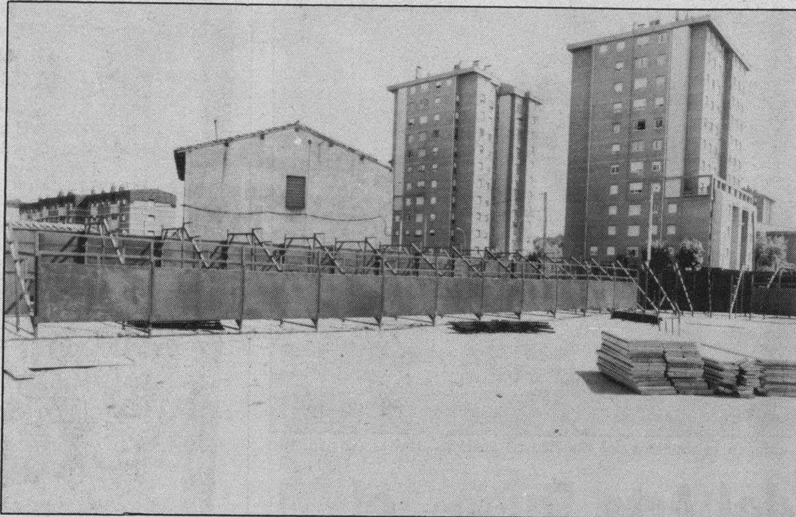
Hace unos días se empezó el montaje de toda la estructura. (Foto: Truchuelo).
