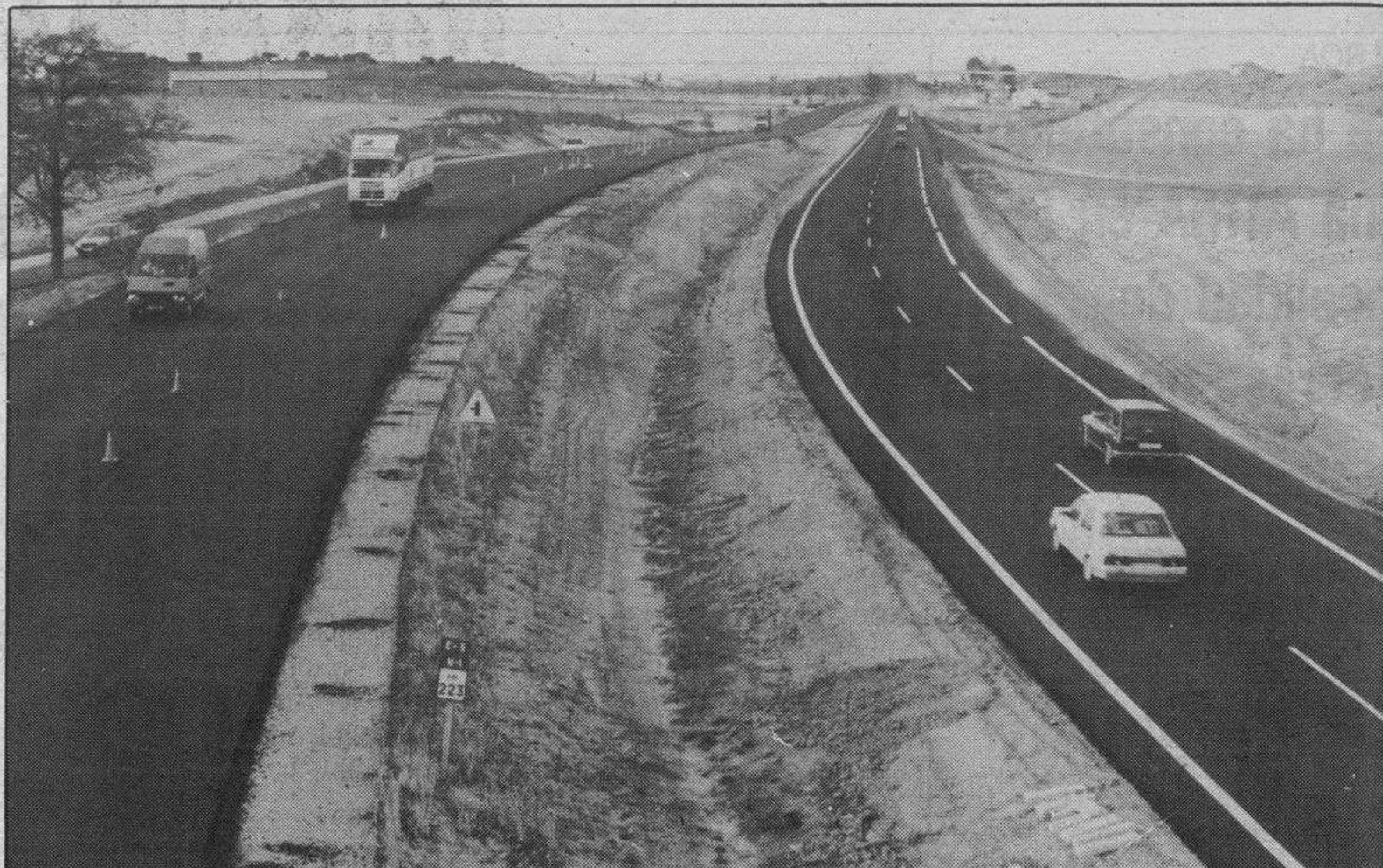
Tramo de la autovía a su paso por la localidad de Lerma.
