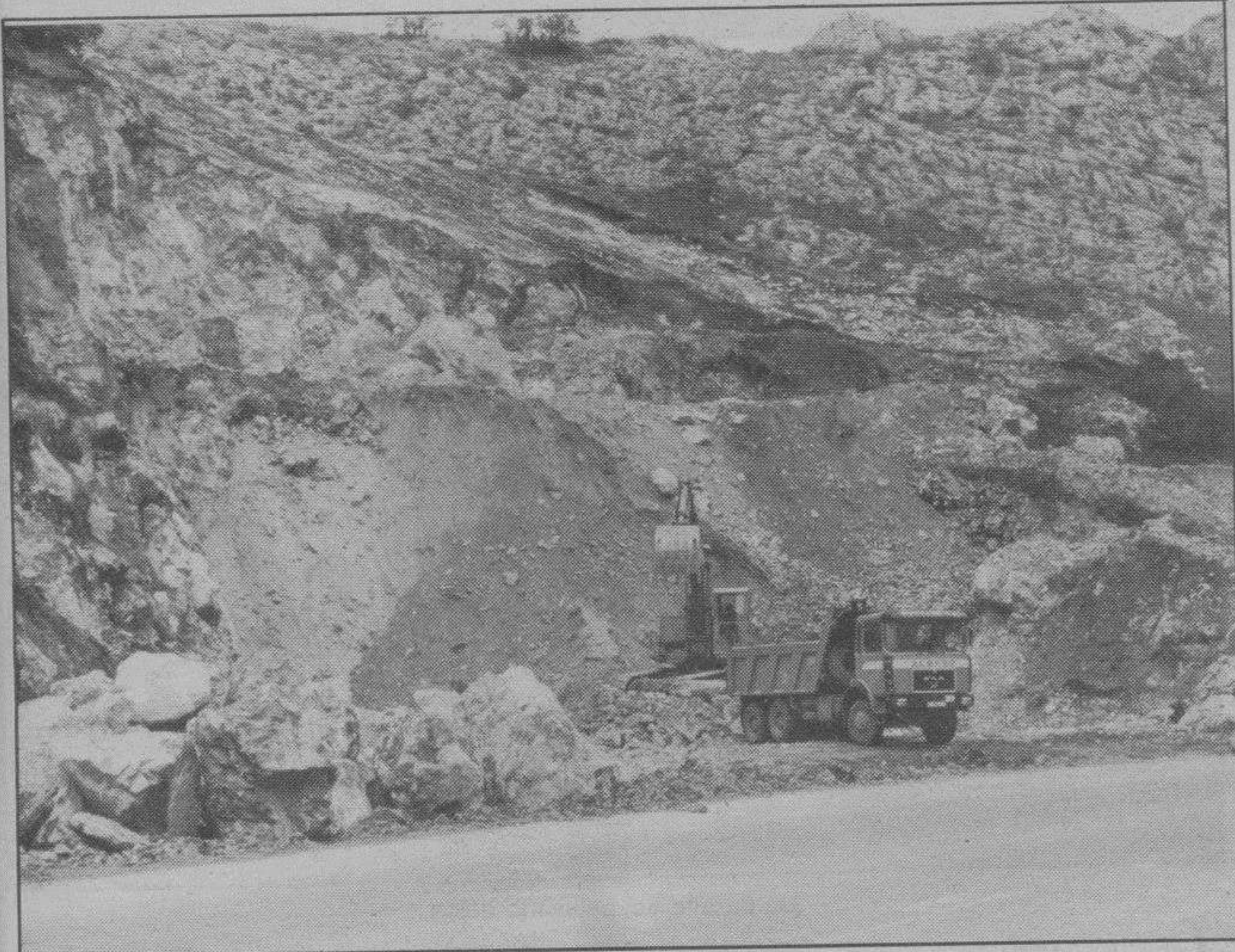
La primera tarea que se hace, antes de dinamitar la montaña, es el desmonte de la tierra hasta llegar a la roca.
