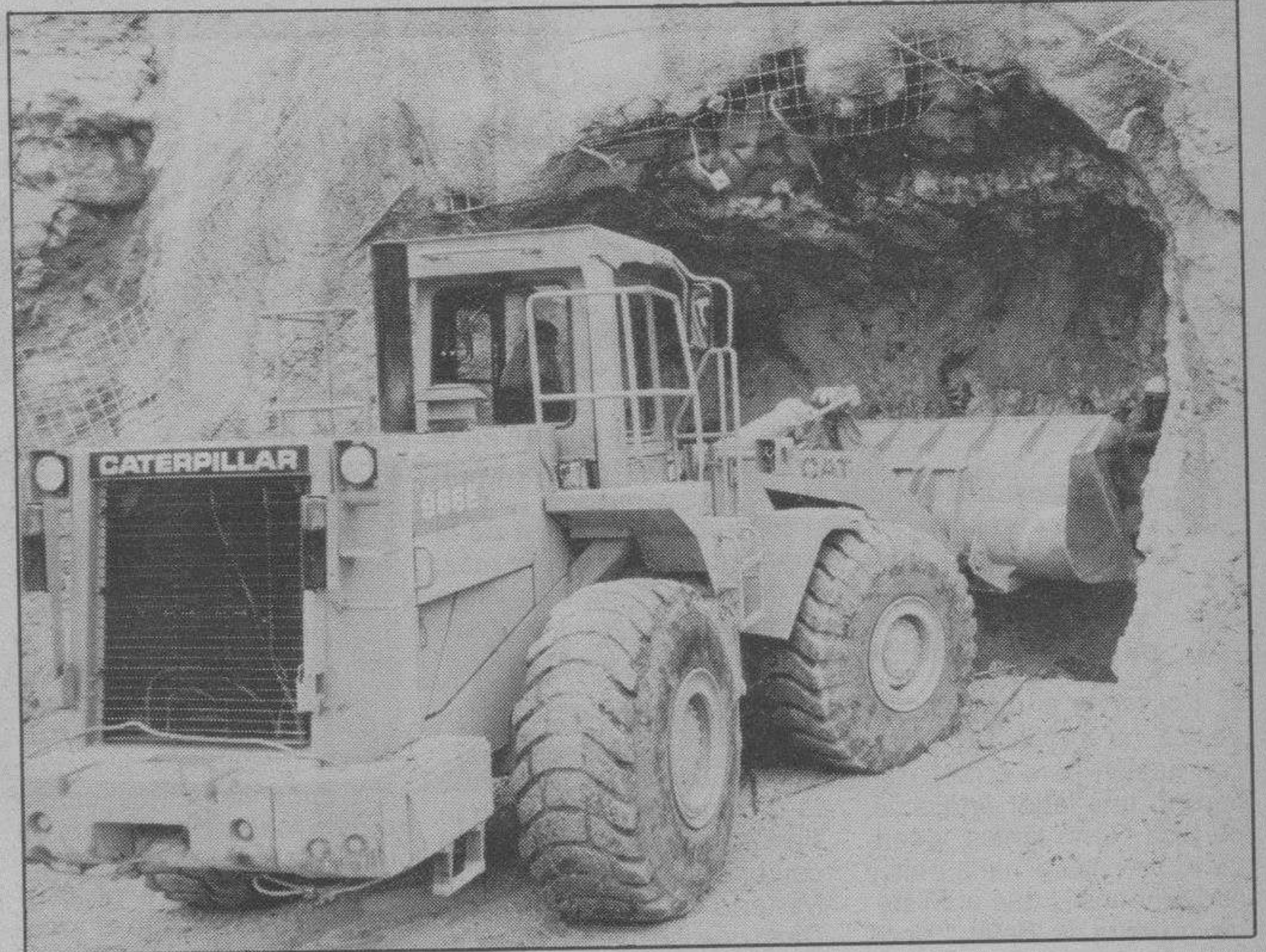
Una vez llegado a la roca, se comienzan a colocar las cargas de Goma-2, con las que se irá dinamitando la montaña.
