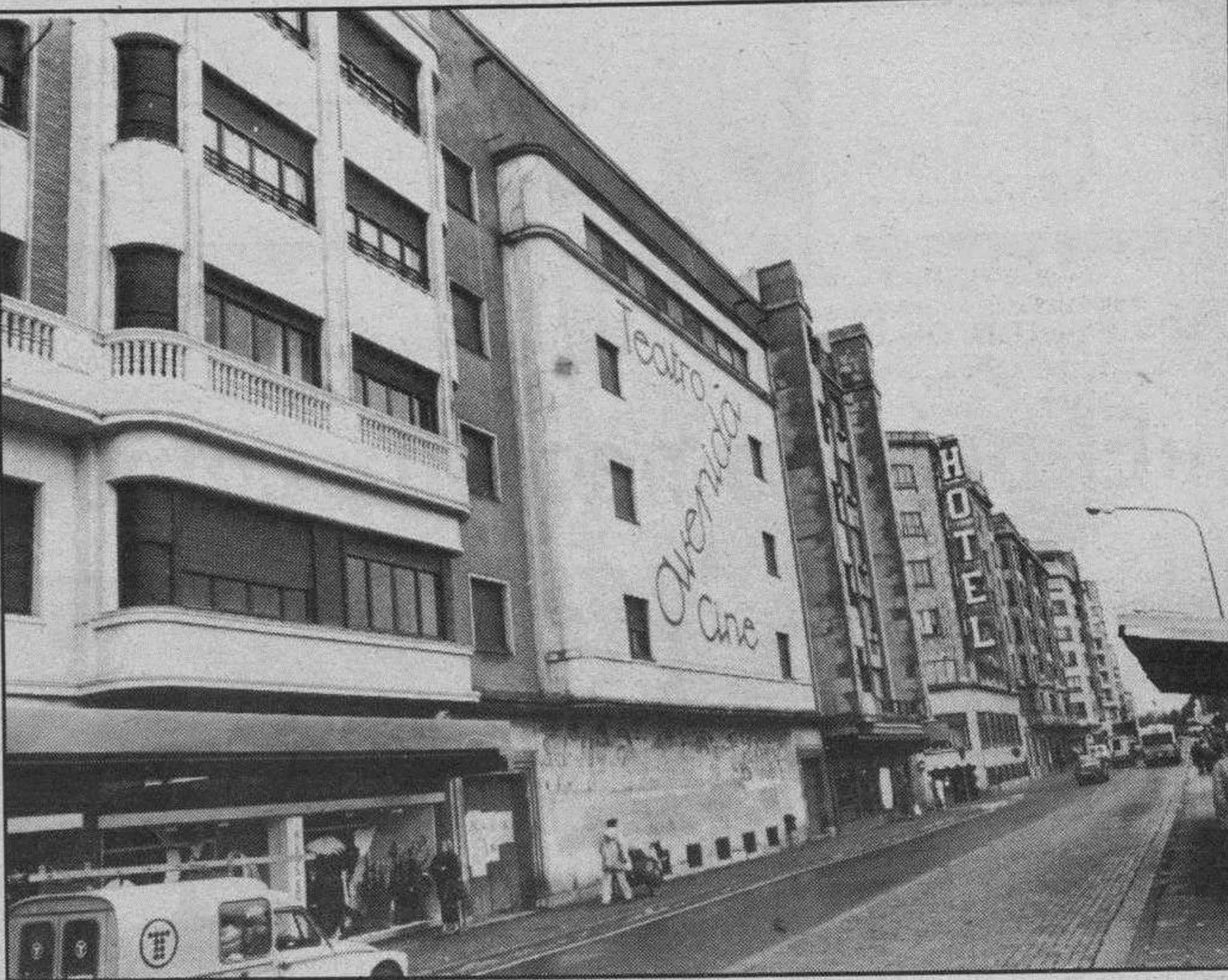
Vista de la fachada posterior del Teatro Cine «Avenida», que permanece cerrado a los espectadores desde el pasado mes de Agosto. Foto: Jesús J. Matías.
