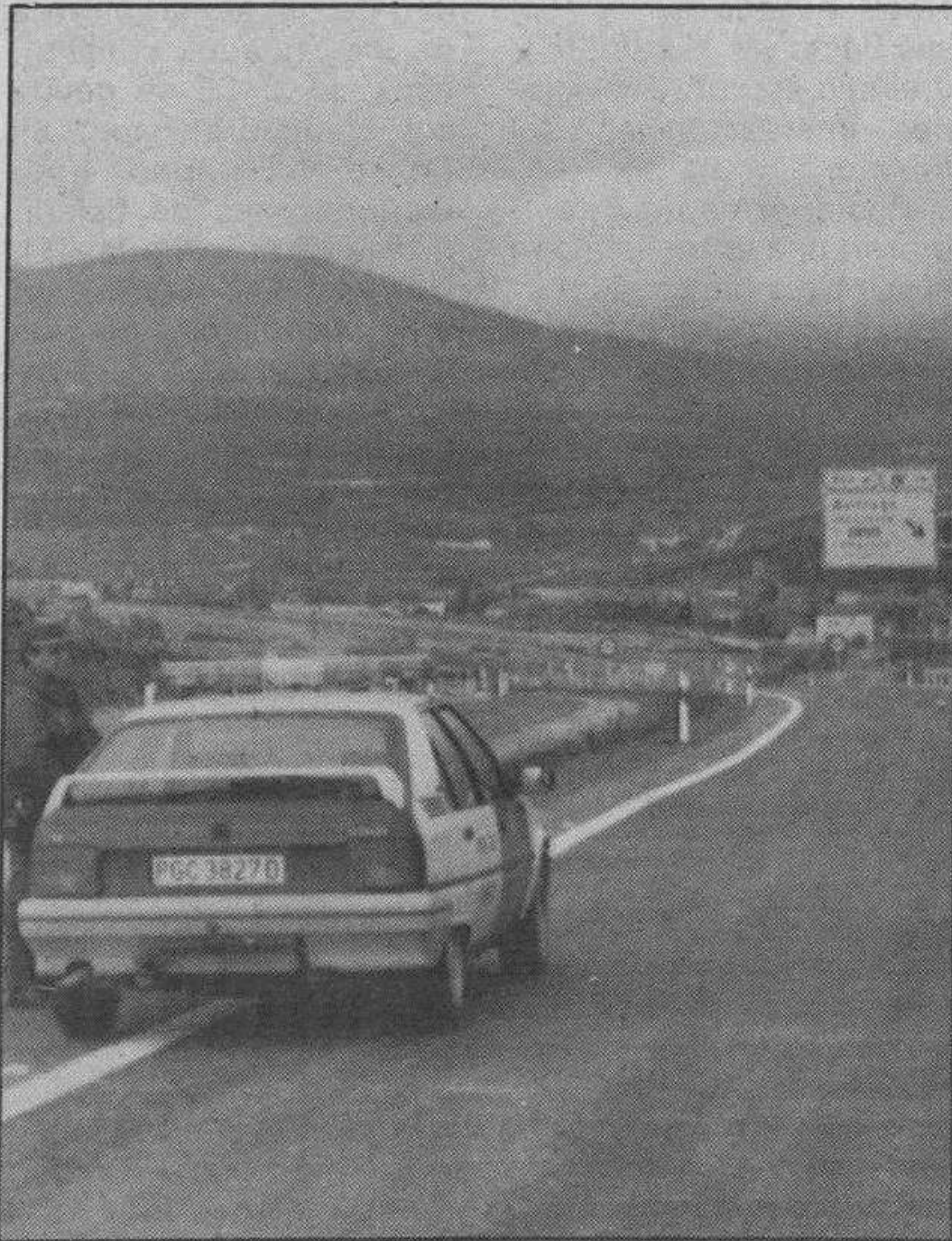
El ministro de Obras Públicas, Cosculluela, puso ayer en servicio ayer la variante de Buitrago. Efe
