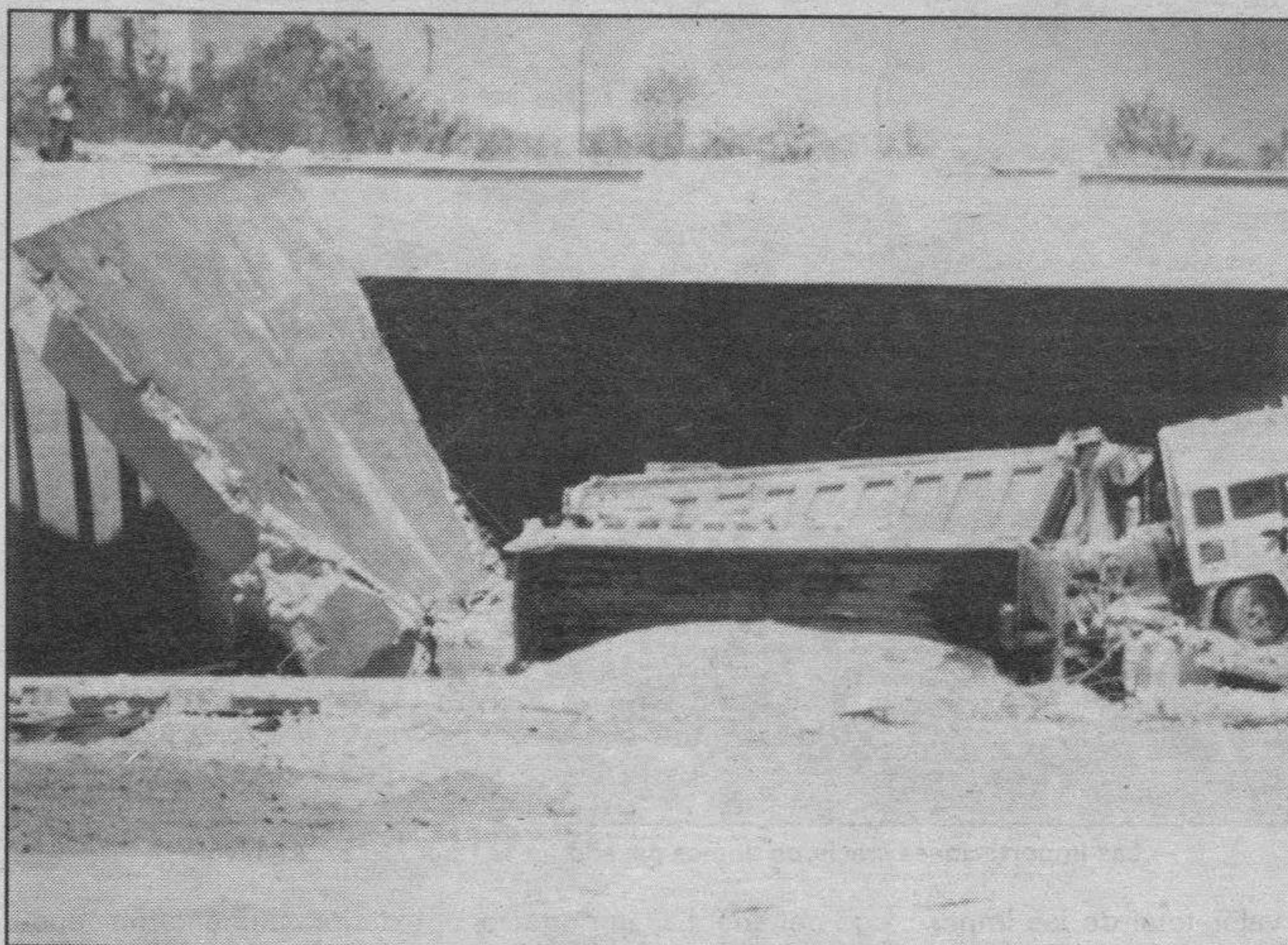
Un herido grave y dos leves es el saldo del derrumbe del techo de un túnel. Foto Efe.
