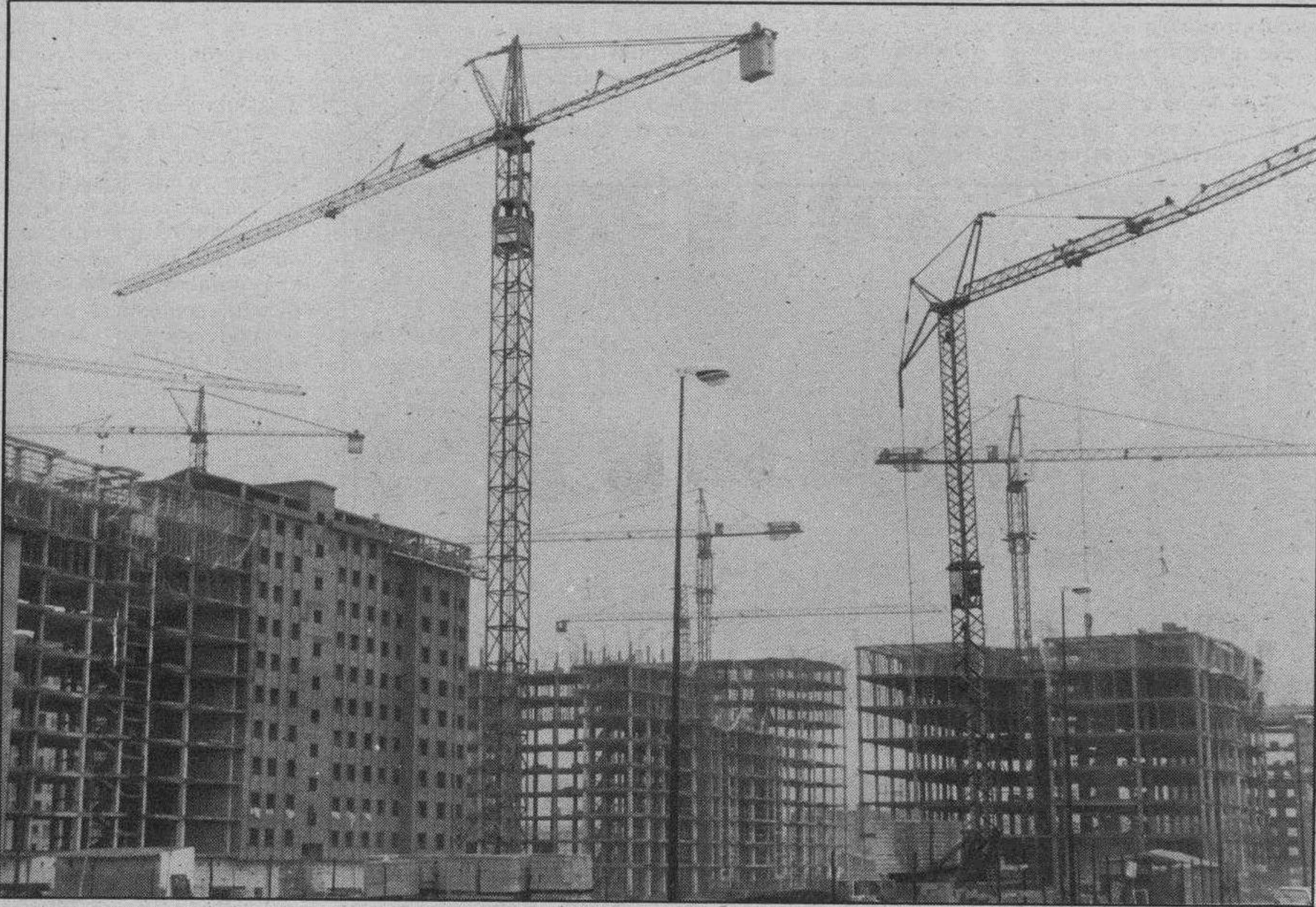
En la década de los ochenta la población en Burgos ha ido creciendo, ello ha exigido la no paralización de la construcción a lo largo de estos años. Foto J. Matías.
