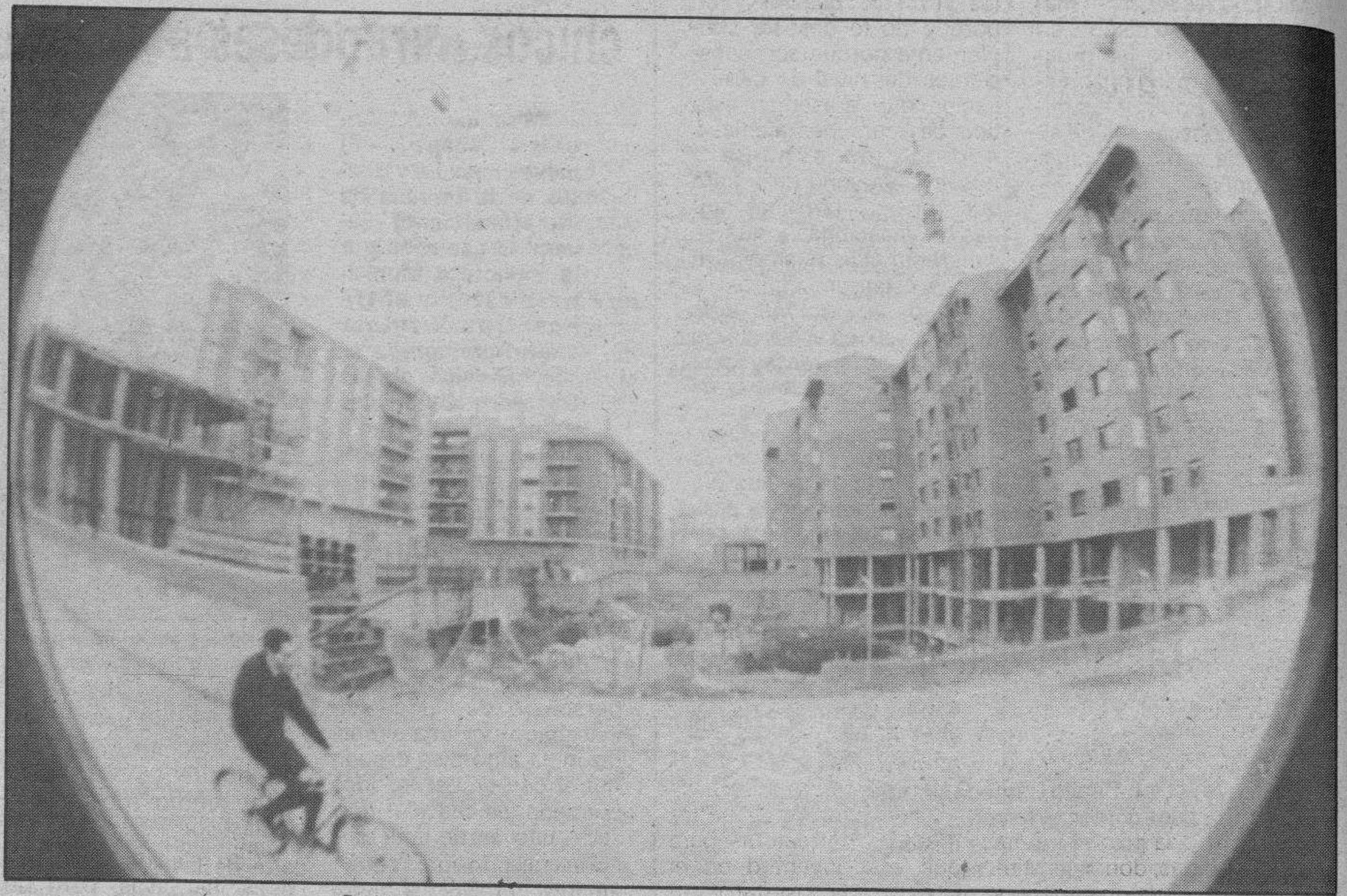
Problemas acuciantes en la Urbanización La Residencia. Foto Lara.
