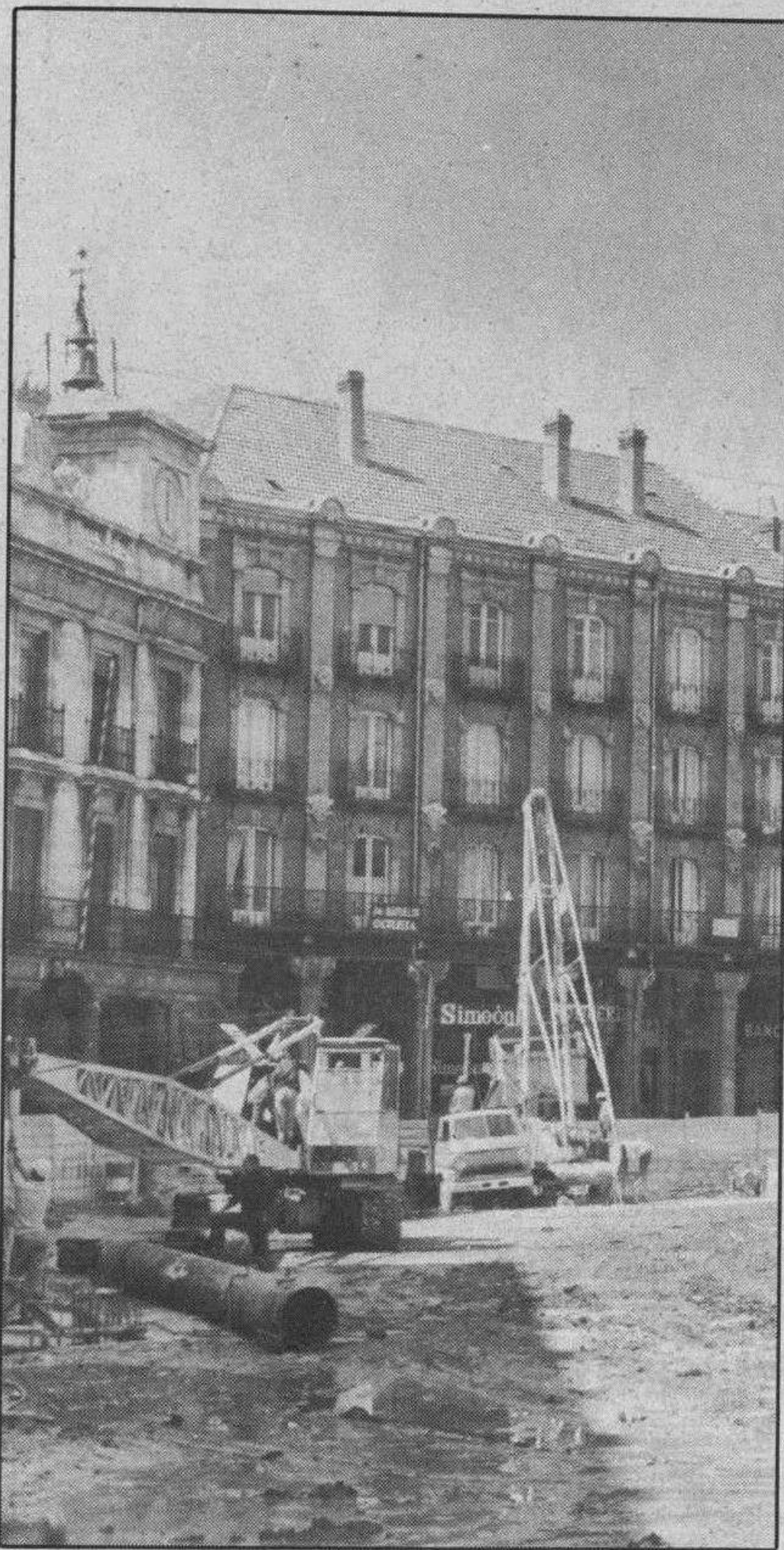
Así estaba el inmueble antes de su reforma. Foto Fede.
