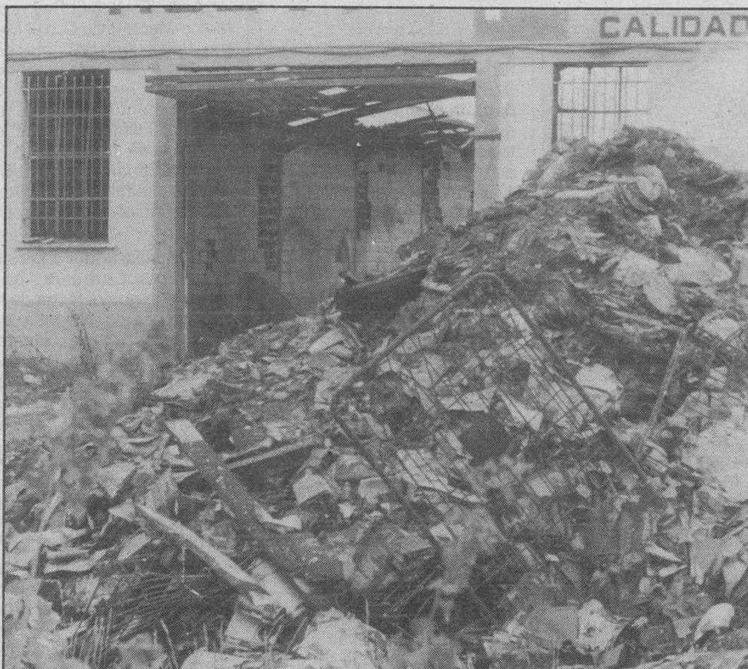
Se valora en varios millones los daños causados por el incendio en una de las naves de la empresa Pascual.
