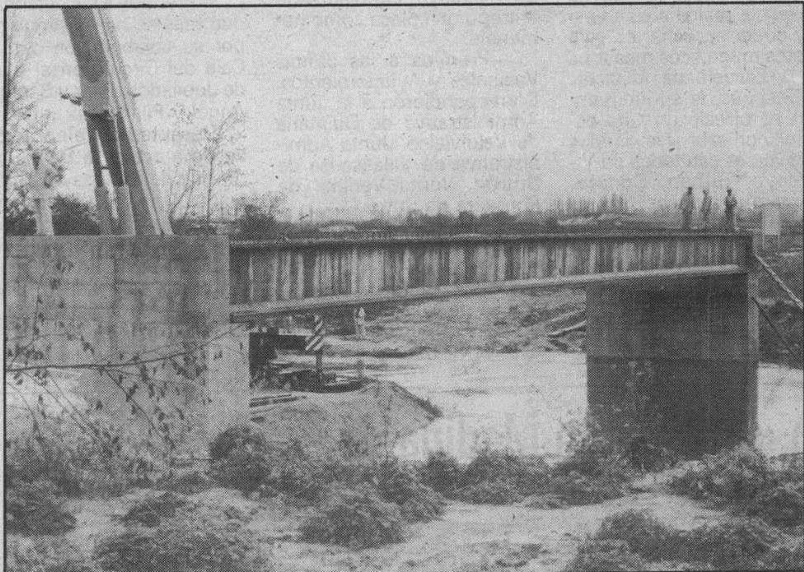
Otra vista del puente que se está construyendo.
