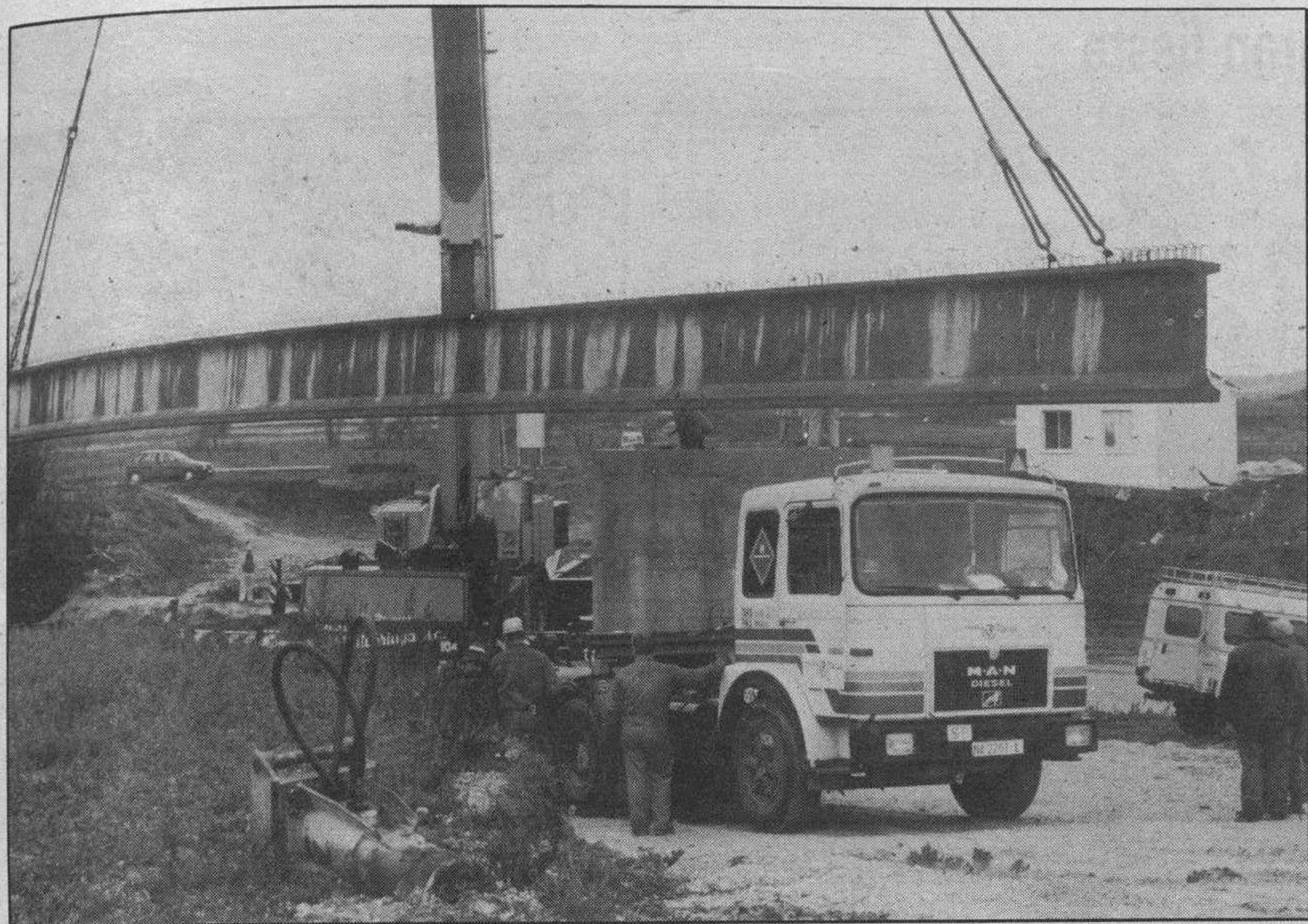
Operación de tendido del puente sobre el Nela.
