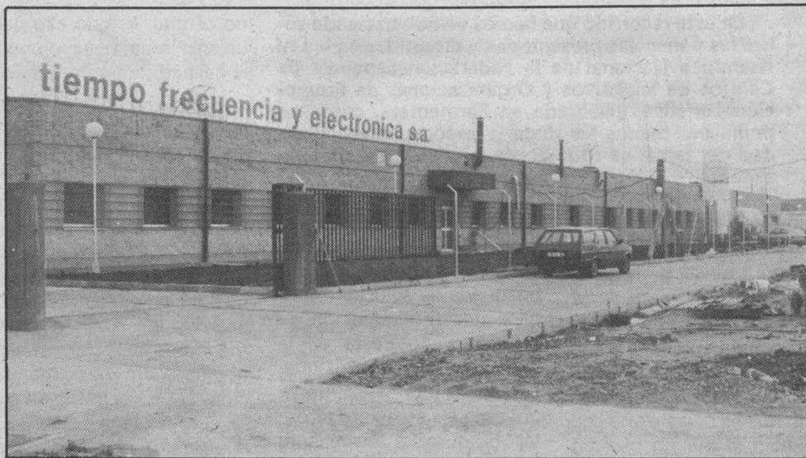
Como estaba previsto, las obras de TFE terminarán el próximo día 16
