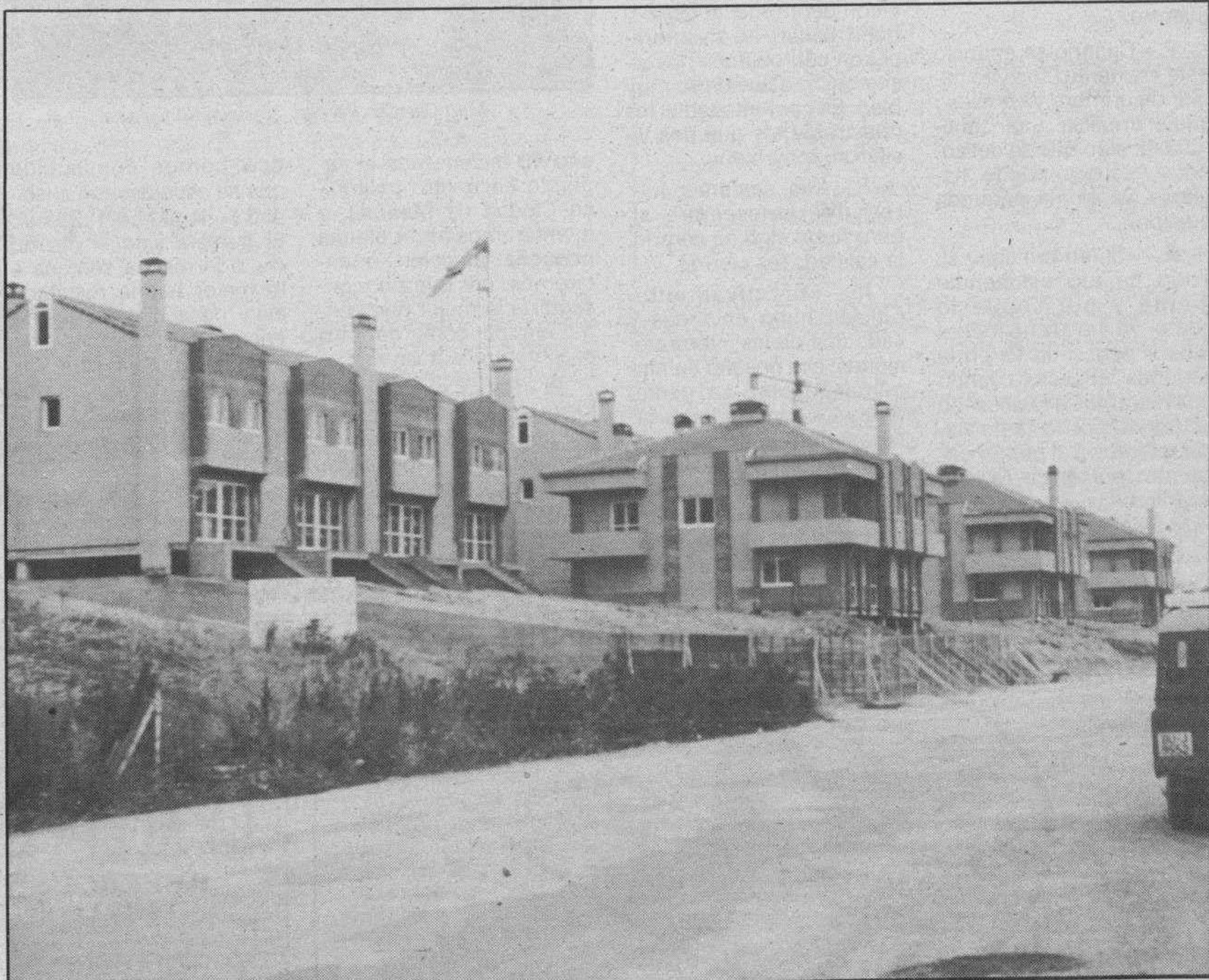
Nueva urbanización residencial que se construye en Briviesca.
