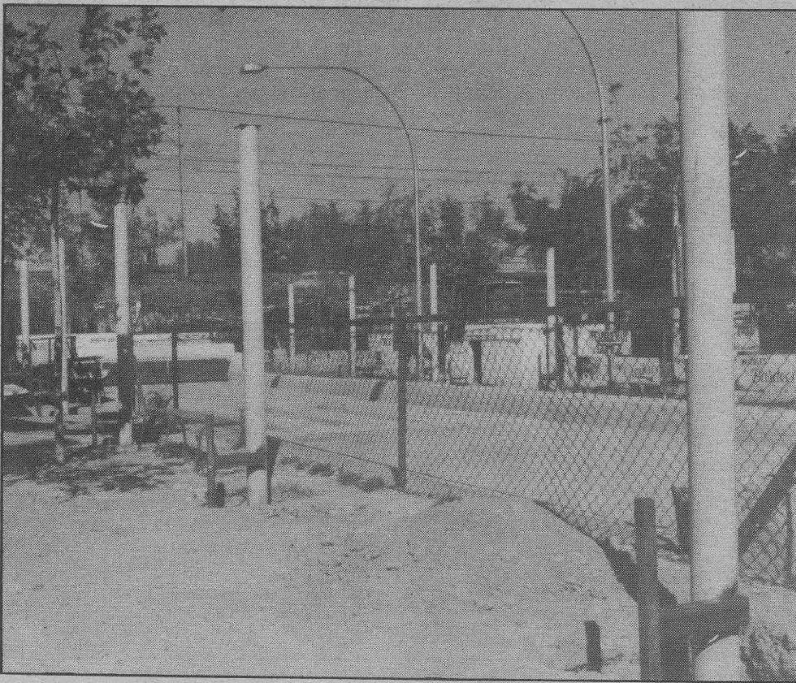
«La colocación de los pilares indica que la aspiración de la Junta directiva de la Bolera Aquende, en el sentido de ver cubiertas las instalaciones, puede ser un hecho dentro de muy pocas fechas. De este modo las competiciones podrán desarrollarse sin pensar en la lluvia u otros agentes meteorológicos». Foto Truchuelo.
