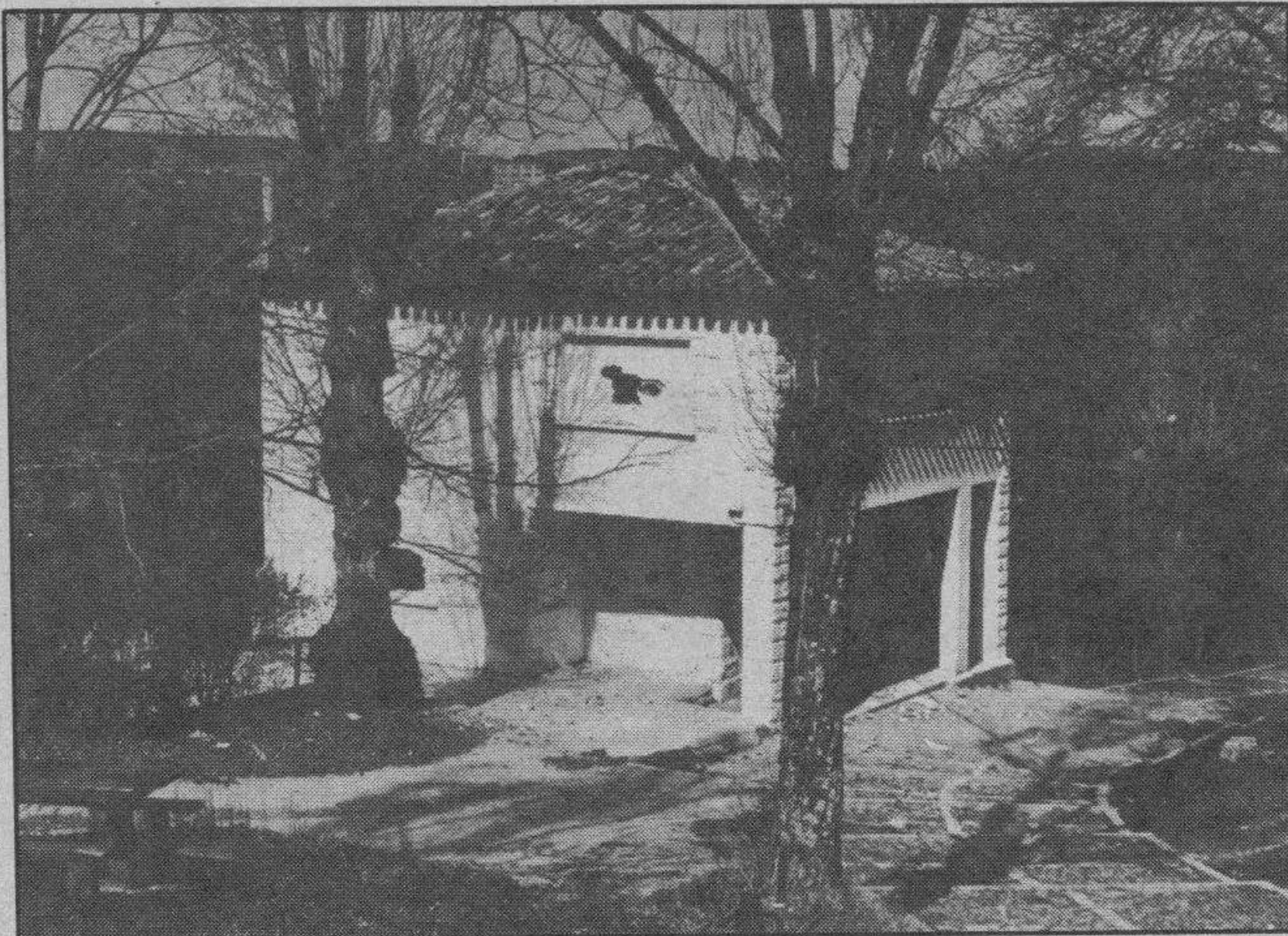
El viejo merendero será demolido para construir el nuevo edificio.
