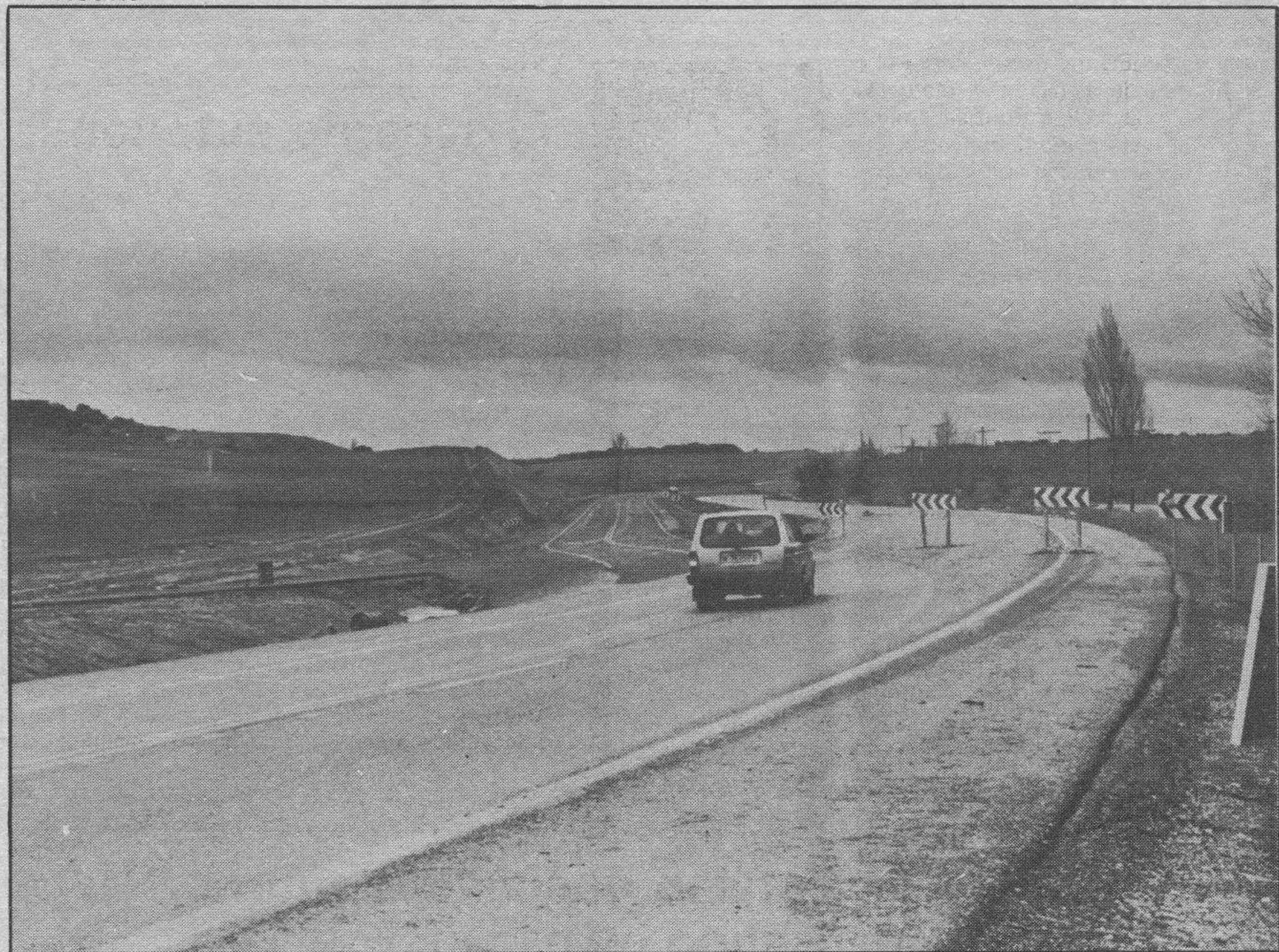
Tramo abierto en la Autovía. — Desde hace unos días, como ya se anunció desde el Gobierno Civil, quedó abierto un tramo de la Autovía Burgos-Madrid a efectos de desviación por las obras que se realizan desde Lerma a Sarracín, donde la actividad es mayor en estos momentos. Algunos automovilistas se quejan de la estrechez de la nueva vía, especialmente en su arcén, aunque sea en su día dirección única, y así los exponemos como opinión que llegó hasta nuestra Redacción.
