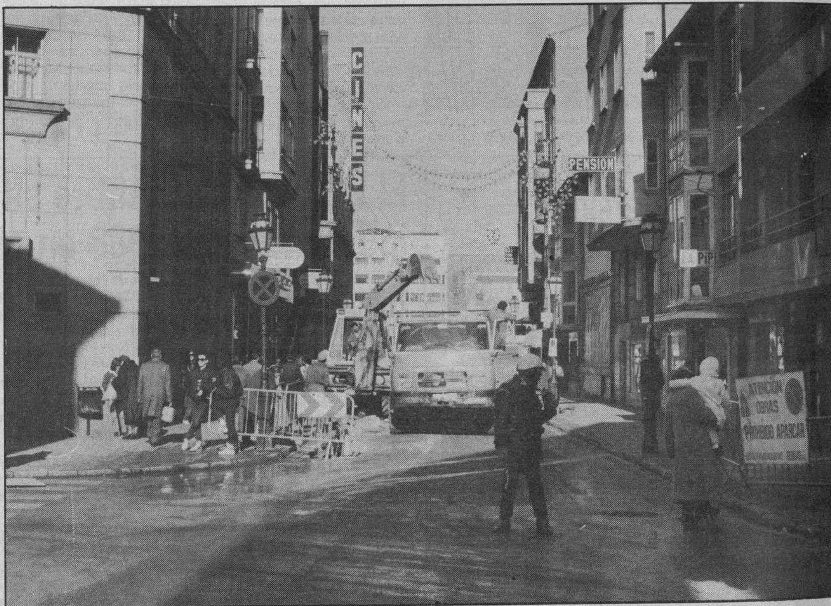
Obras del gas. —Una nueva etapa de extensión de las redes del gas natural se inicia ahora, cuando se han batido todos los records en la previsión que se había hecho. Las peticiones van más allá de lo que se programó, pese a que las obras se encuentran en muchas zonas y se trabaja con gran celeridad para tratar de complacer las numerosas peticiones de esta nueva energía que se une a las que ya había en Burgos.
