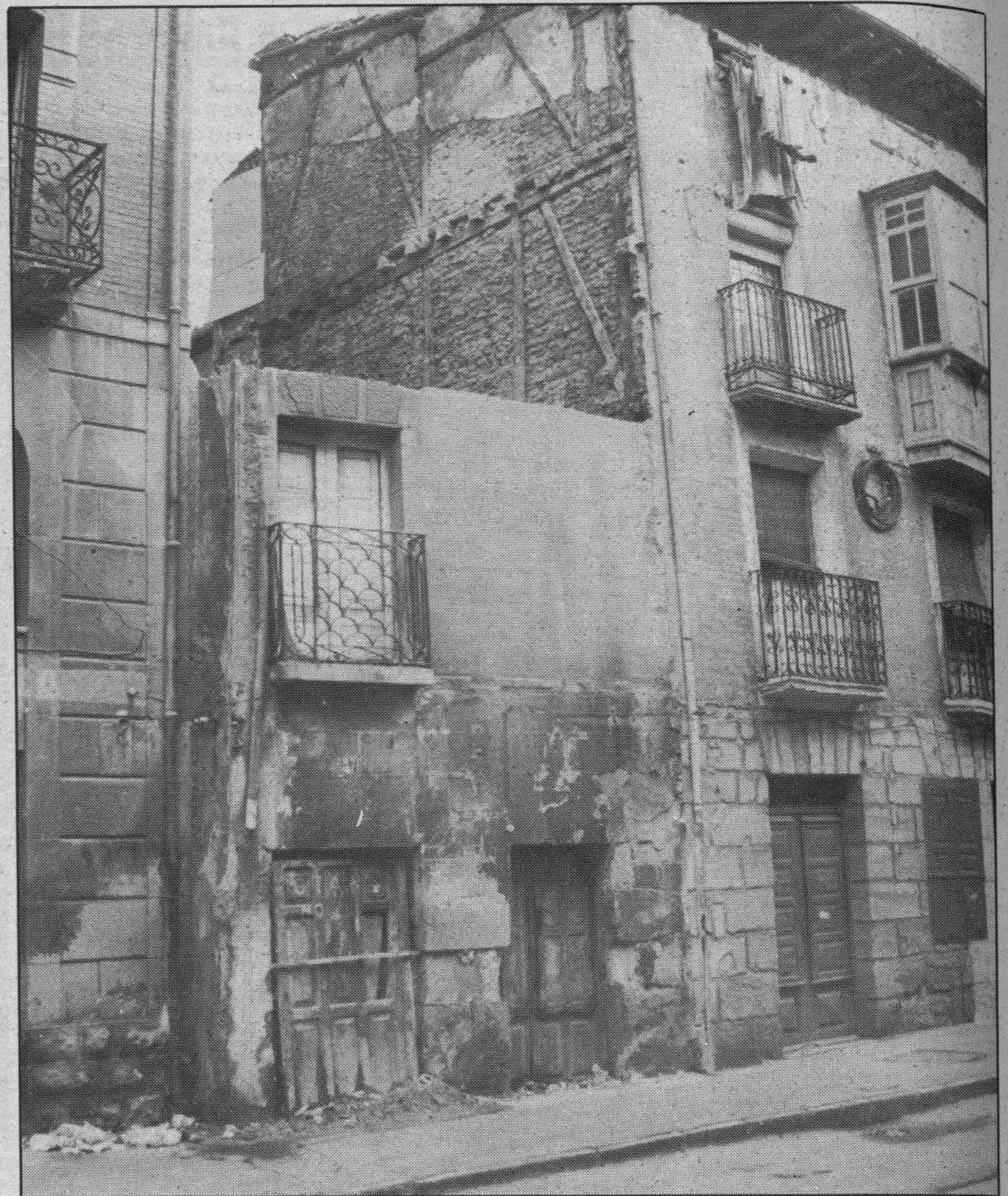
Más derribos en Aquende. — En esta ocasión en la Plaza de Santa María. La imagen que nos ofrece Truchuelo de una casa semiderribada, ha dado paso a un solar, no muy grande, más bien pequeño, pero en esta ocasión si no surgen inconvenientes, será utilizado de inmediato para construir otro edificio, de escasa entidad, claro, pero de acuerdo con lo que requiere el barrio. Ojalá que ocurra lo mismo con todos esos solares que existen desparramados por Aquende, que está ganando en popularidad y en urbanización, pero que por falta de viviendas, se va quedando vacío de vecinos.
