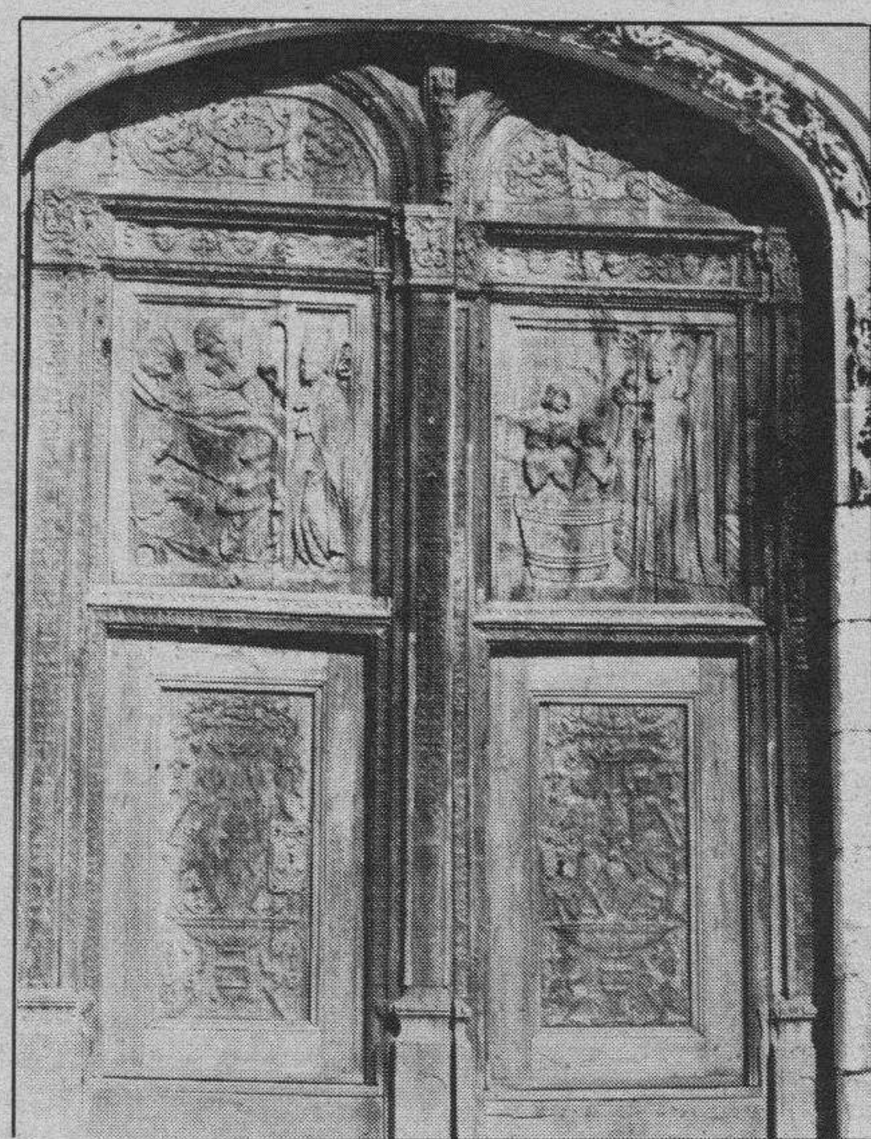
Nuevo aspecto que presentan las puertas platerescas. La madera ha cobrado su color natural de nogal y roble.
