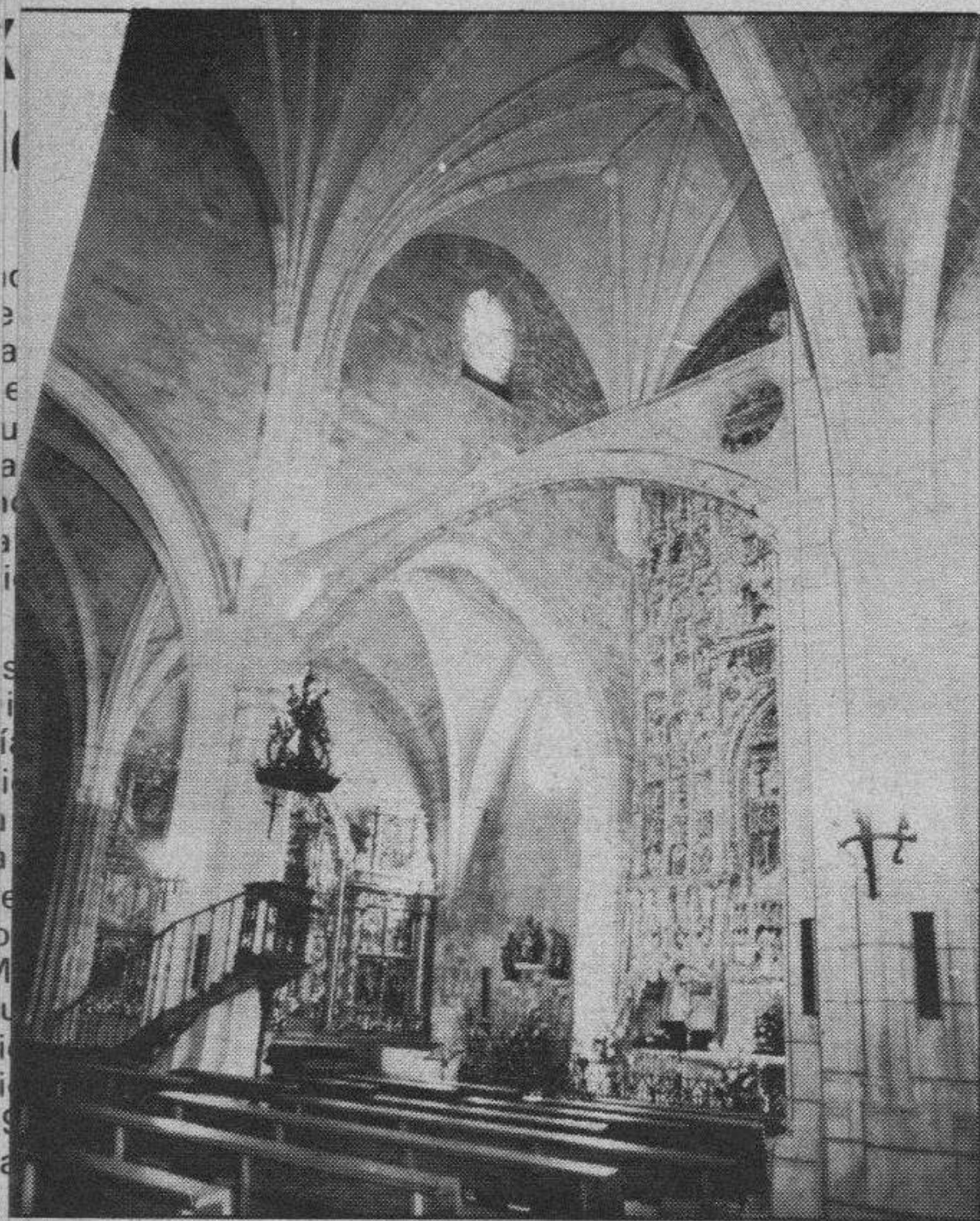
Hermosa vista en la que se aprecia la restauración de bóvedas, muros y del arco de los querubines.
