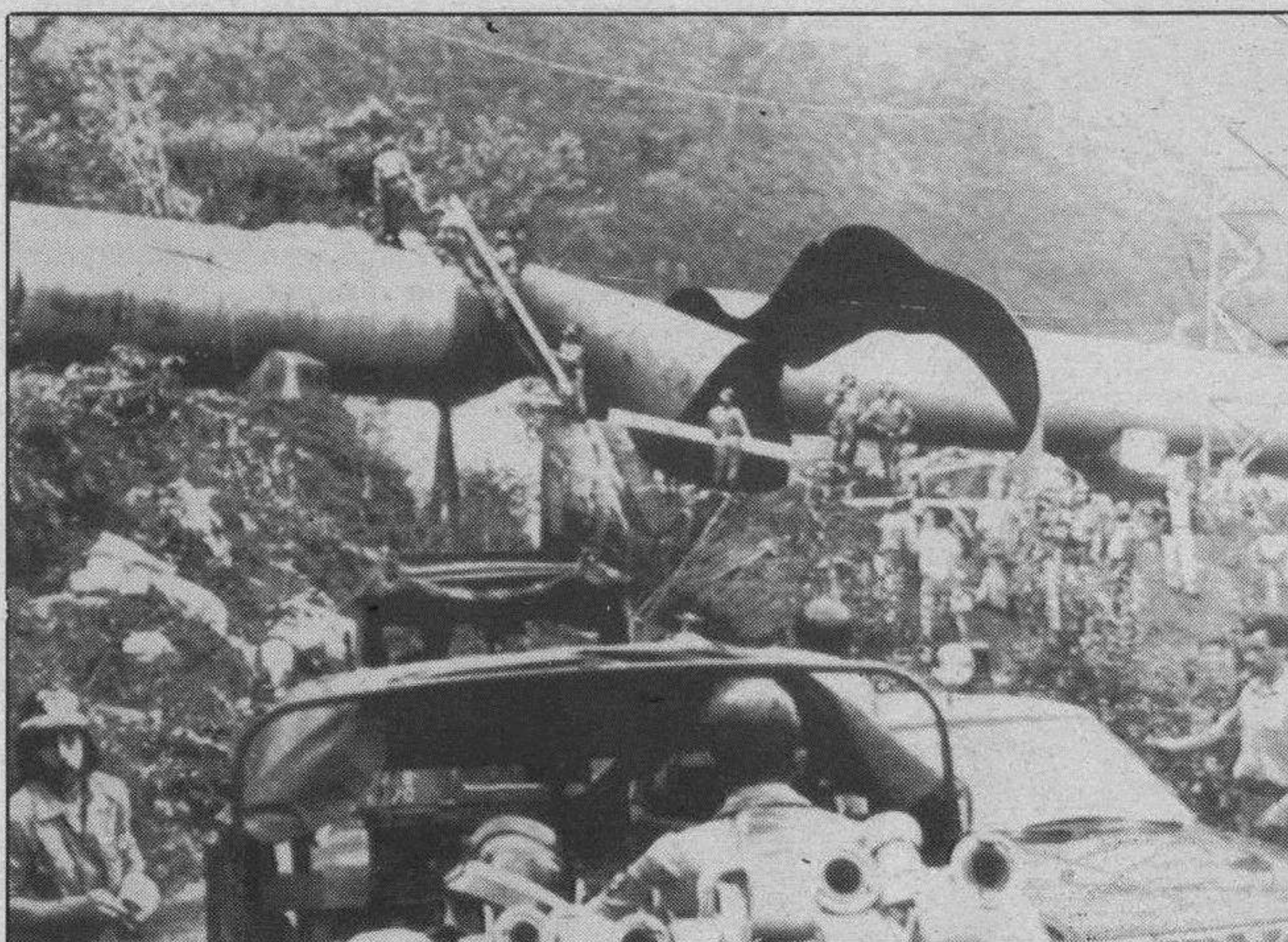
Una dotación de bomberos, en el lugar en que explotó una conducción de agua de alta presión de una hidroeléctrica. El suceso ocurrió en el Alto Adigio, cerca de Merano (Italia). La explosión causó daños en el pueblo y las carreteras.— AP-Efe.
