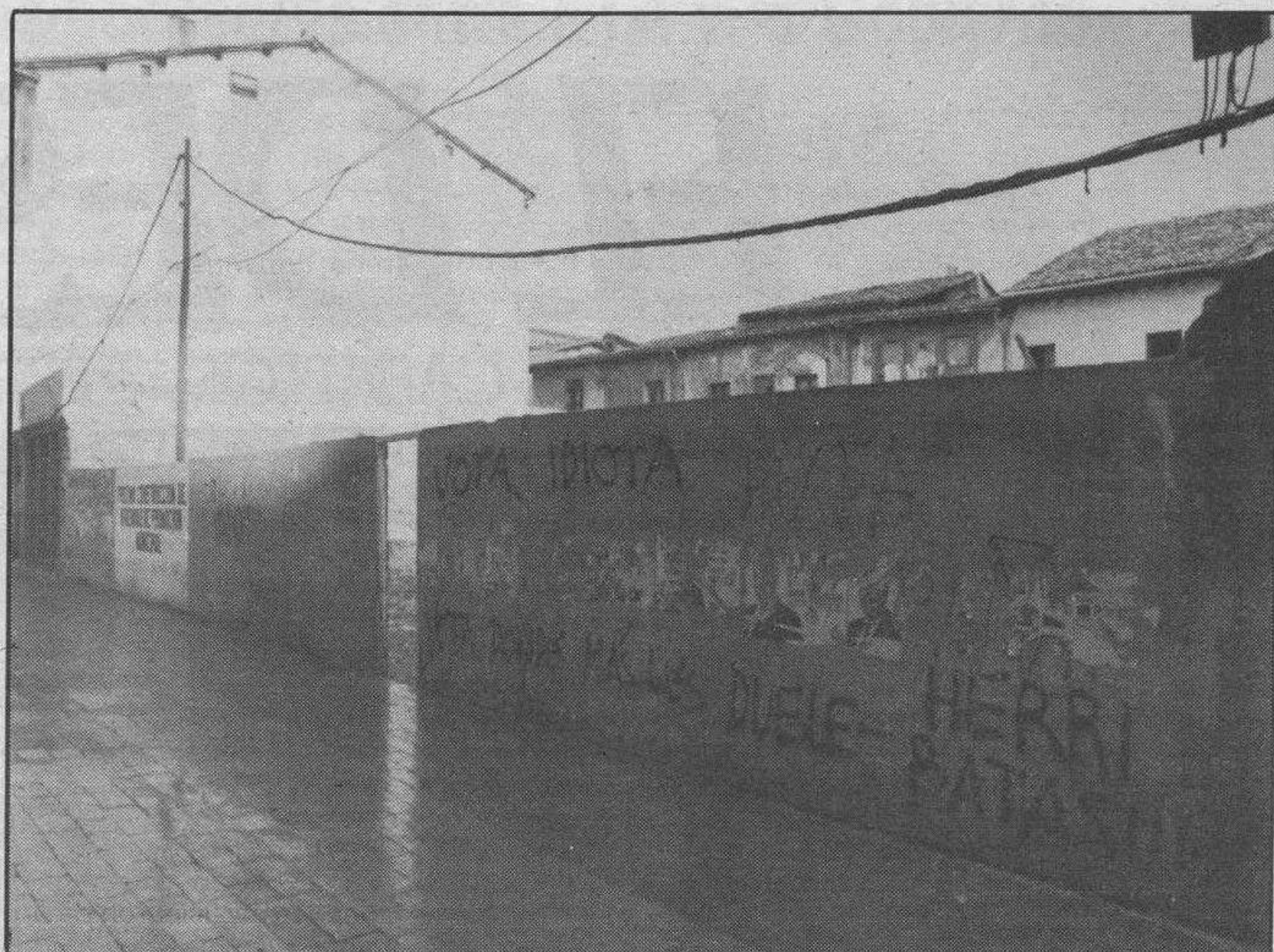
El solar de la calle de San Juan. — O de la calle de Los Hornos, que tanto monta, porque este hermoso solar resultante del derribo de varias casas en ruinas abarca las dos calles y las nuevas edificaciones a las dos calles tendrán fachadas. Este solar lo tiene destinado el Ayuntamiento para construir 24 viviendas de promoción municipal y protección oficial y parece ser que será pronto cuando comience la construcción de esas viviendas. Precisamente el día uno de Febrero en la asamblea general de la Asociación de Vecinos del Casco Viejo en su punto primero del orden del día se informará sobre esas proyectadas 24 viviendas. Importante este asunto por cuanto supone un paso más hacia la recuperación del casco antiguo.
