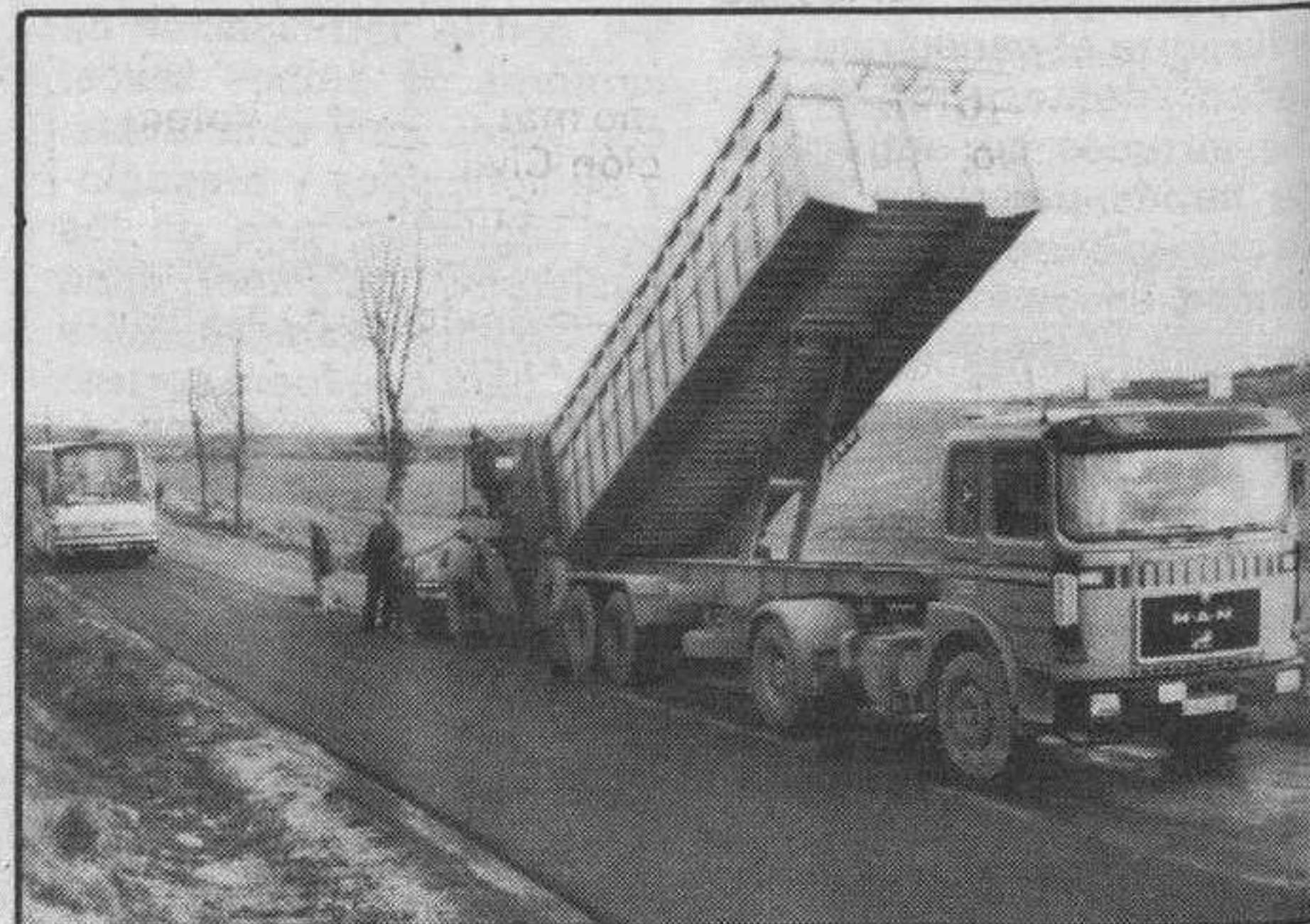
Echando firme bituminoso en la bajada del páramo hacia el Rudrón.
