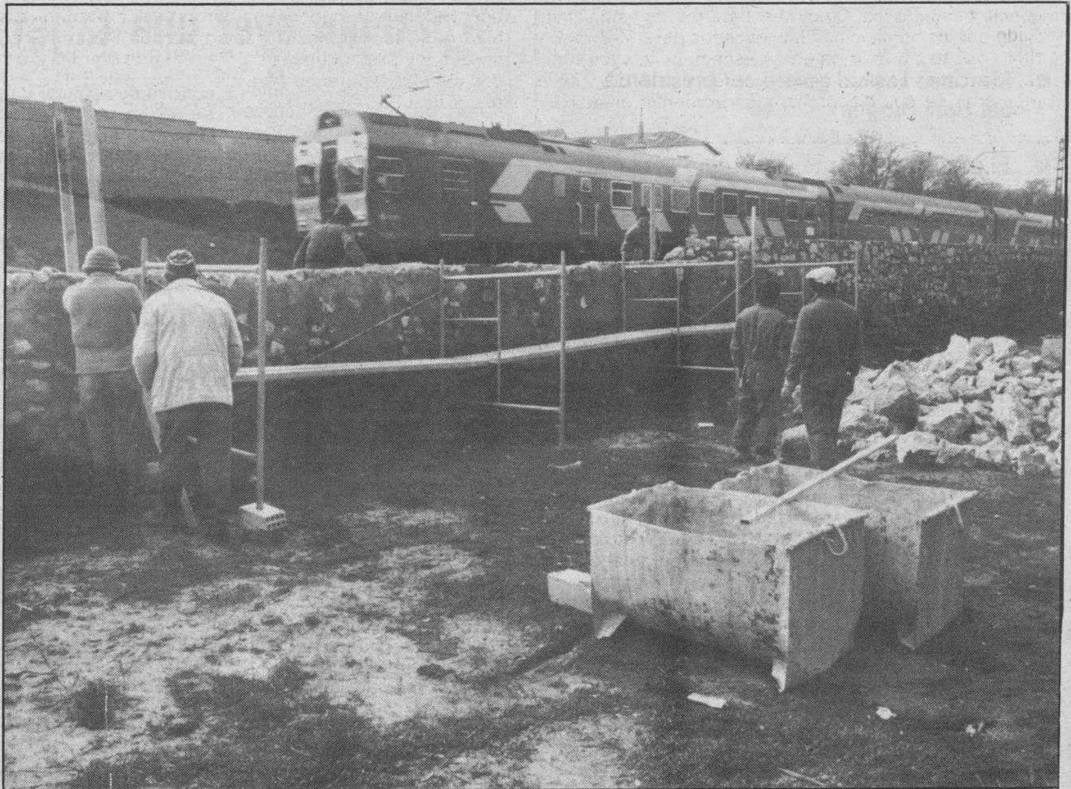
El tren y la tapia. — Se están realizando los trabajos de reconstrucción de la tapia del ferrocarril en las traseras de Santa Clara. La fotografía de Pedro Antonio nos muestra esas tareas. Lo importante no es que se haga ahora más tapia, sí que se arbitren soluciones para deprimir la vía y recuperar para la ciudad una fisonomía propia, distinta y moderna.
