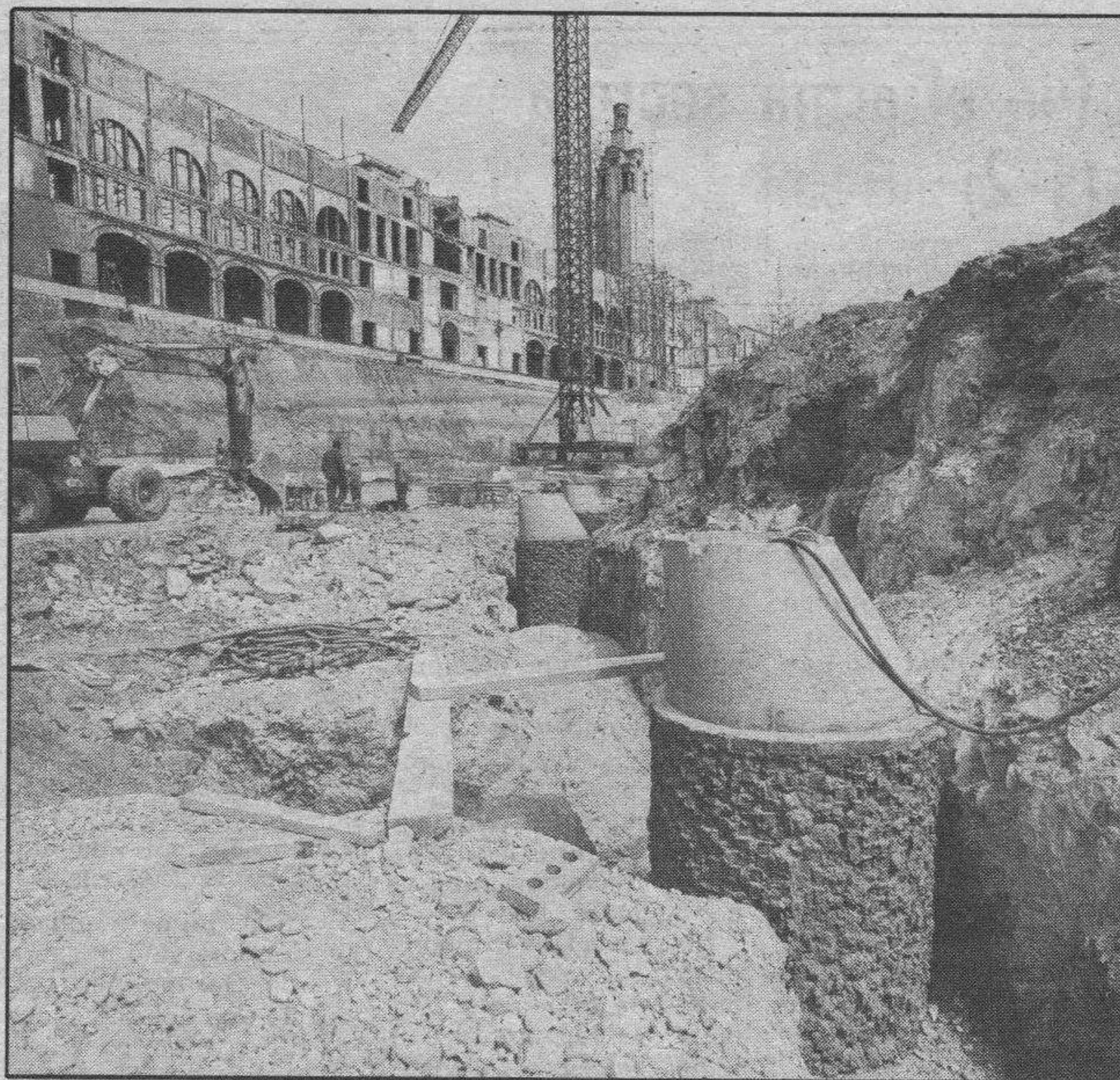
Las obras de Barcelona 92 van a buen ritmo
