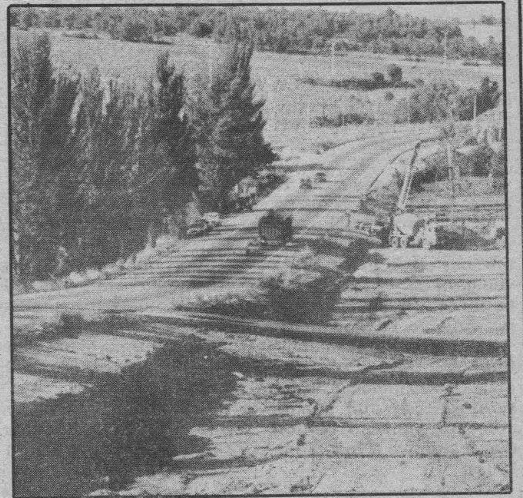
Se renovarán varios pavimentos de nuestras carreteras.
