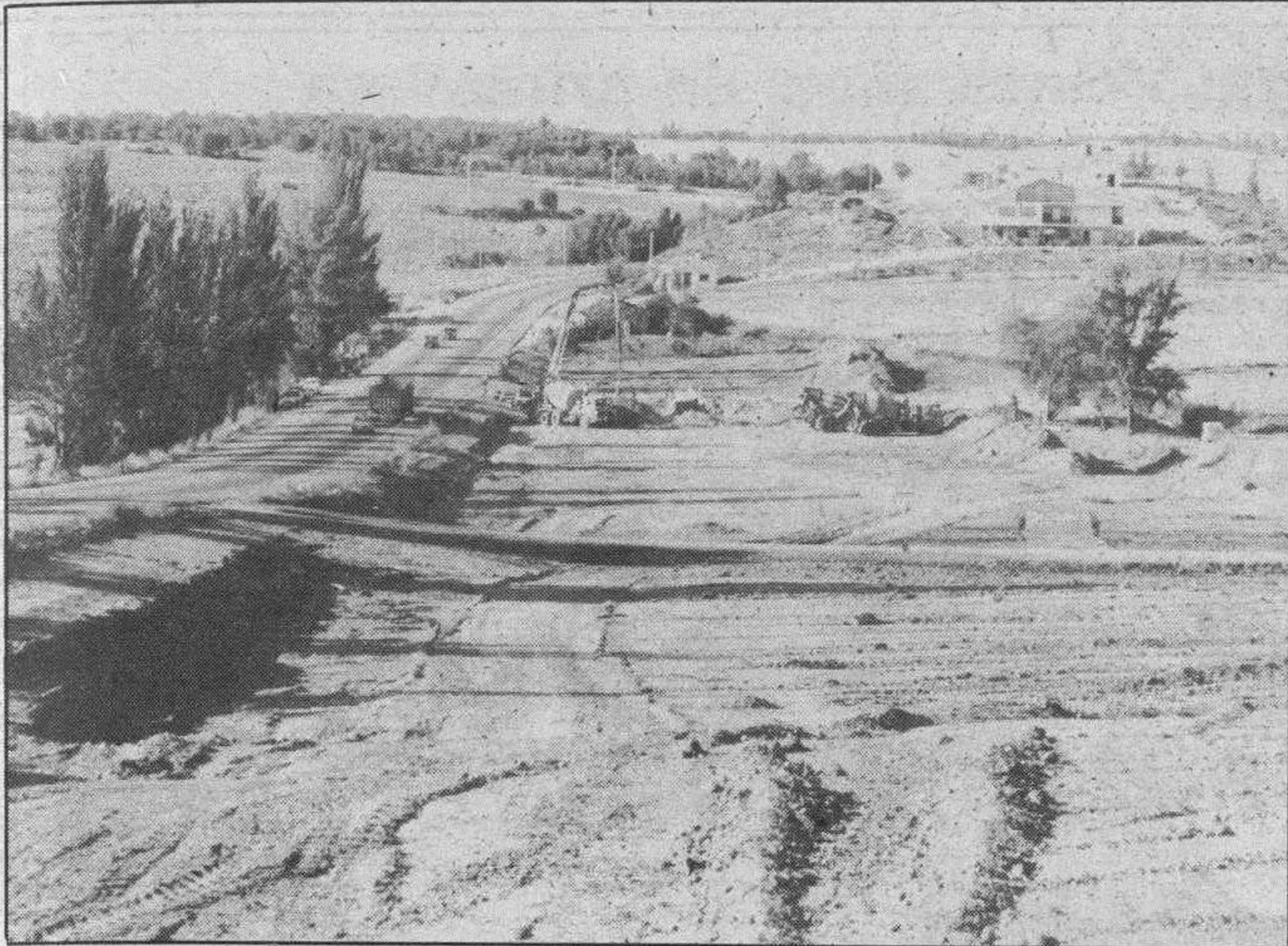
El tramo Lerma-Sarracín, ha sido el primero de la provincia en comenzarse las obras.
