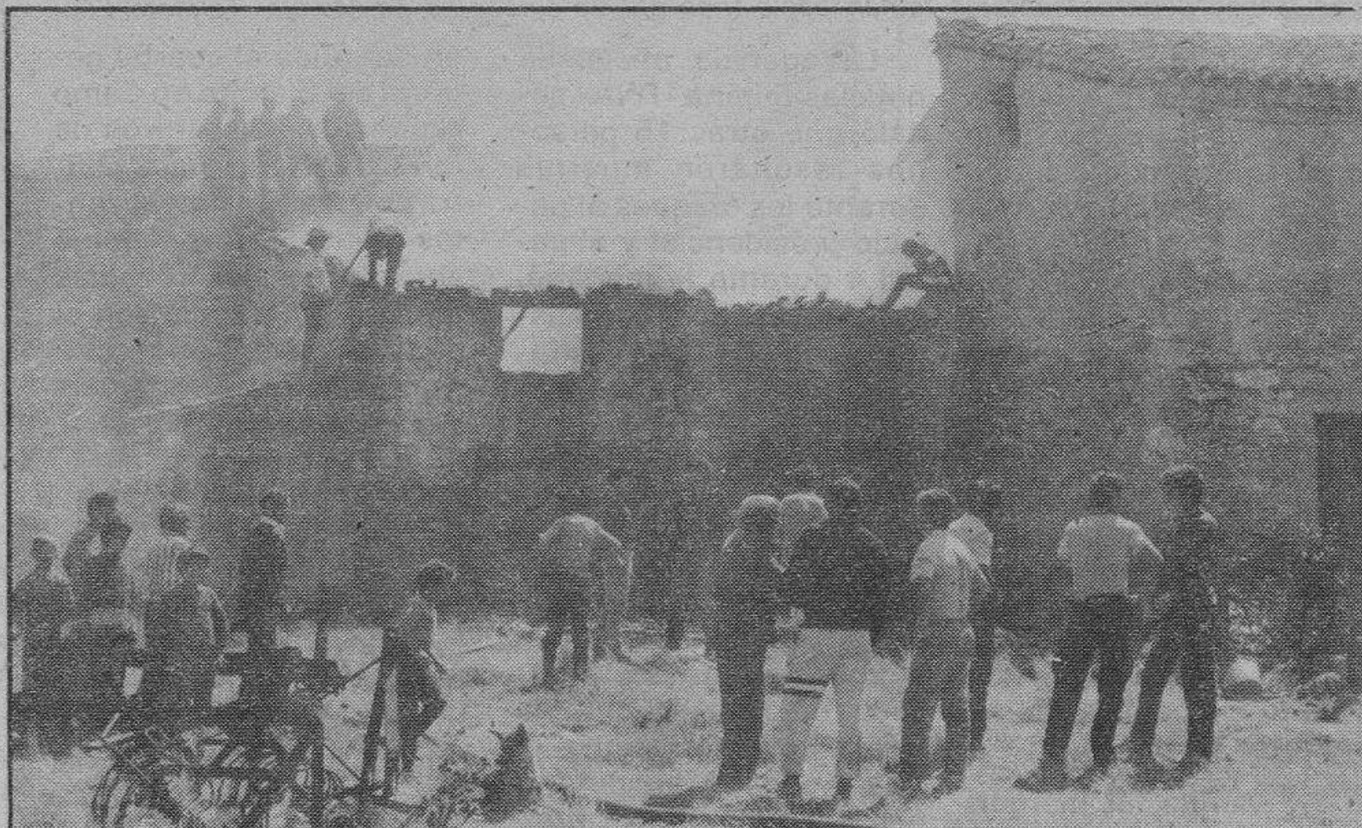
Los daños causados por el fuego ascienden a más de un millón de pesetas.
