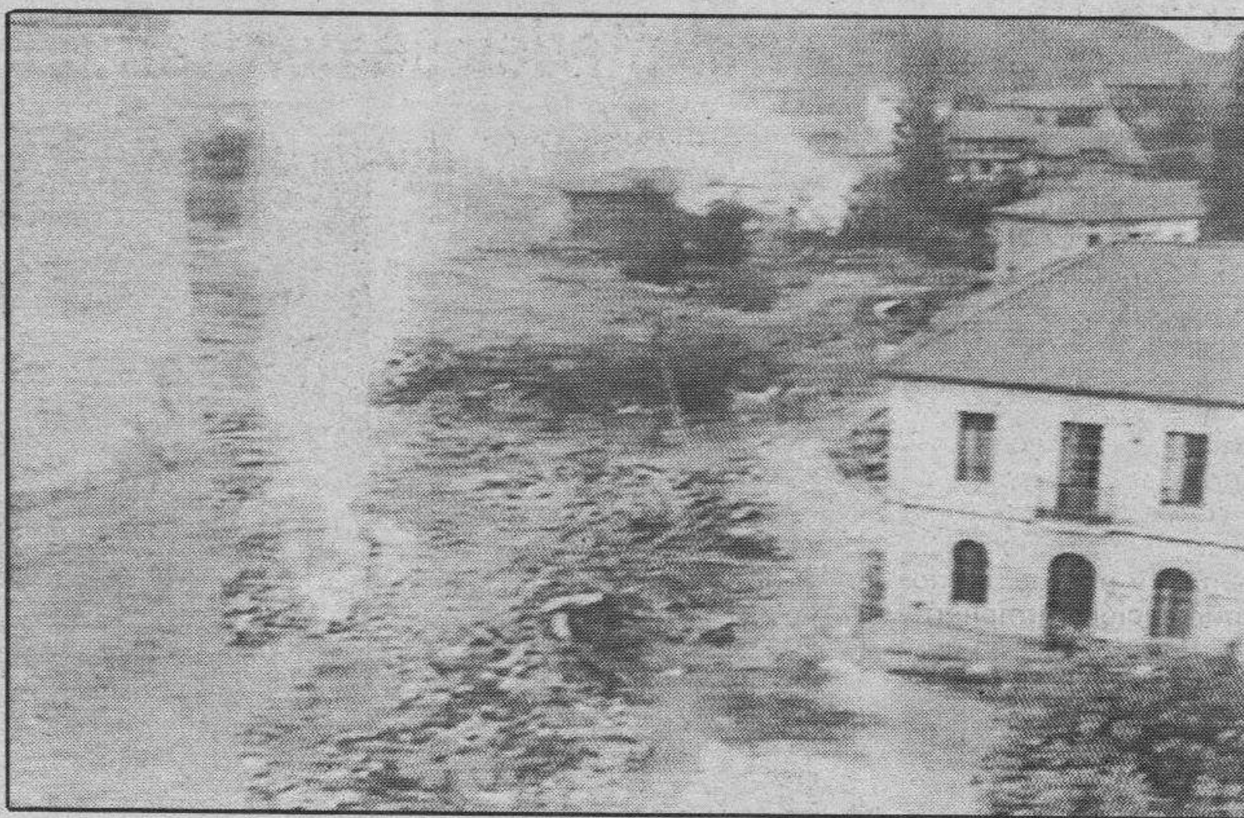
Ayuntamiento de Riaño, uno de los últimos edificios a demoler.
