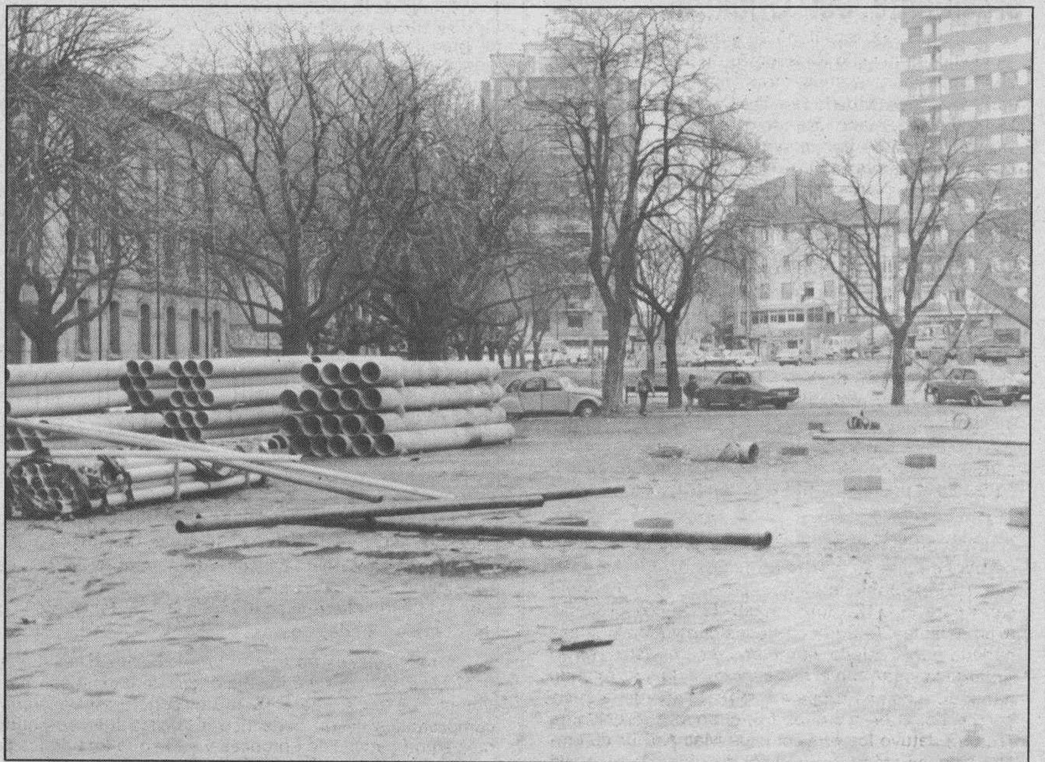
Comienzo de los trabajos en el Parque de San Agustín. — Con el acopio de materiales se han iniciado los primeros trabajos para ejecutar un proyecto de especial interés en el orden urbanístico, el nuevo Parque de San Agustín que será adecentado y mejorado con la aportación del Ayuntamiento y la Diputación Provincial.
