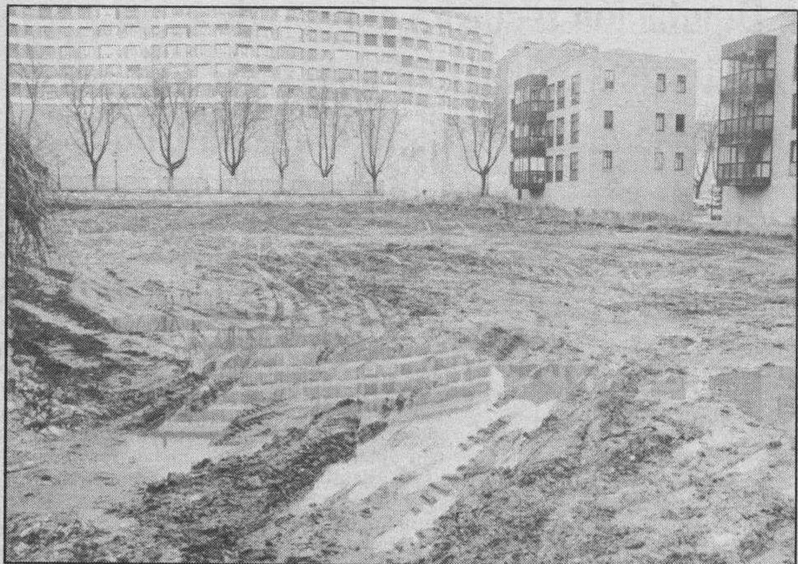
El Centro de Salud de Los Cubos. — Después de un largo compás de espera desde que se iniciaron las operaciones de replanteo, han comenzado las obras de construcción del Centro de Salud Los Cubos que el INSALUD adjudicó en Diciembre del pasado año a la empresa «Alejandro Bolado» en 53.526.463 pesetas, de acuerdo con el anteproyecto «Sara 3» y que ganó el concurso convocado por el INSALUD en Octubre del mismo año. Problemas en la fase del replanteo obligaron a retrasar el principio de las obras en una parcela que por un lado mira al paseo de Los Cubos y por otro a la calle Lavadores.
