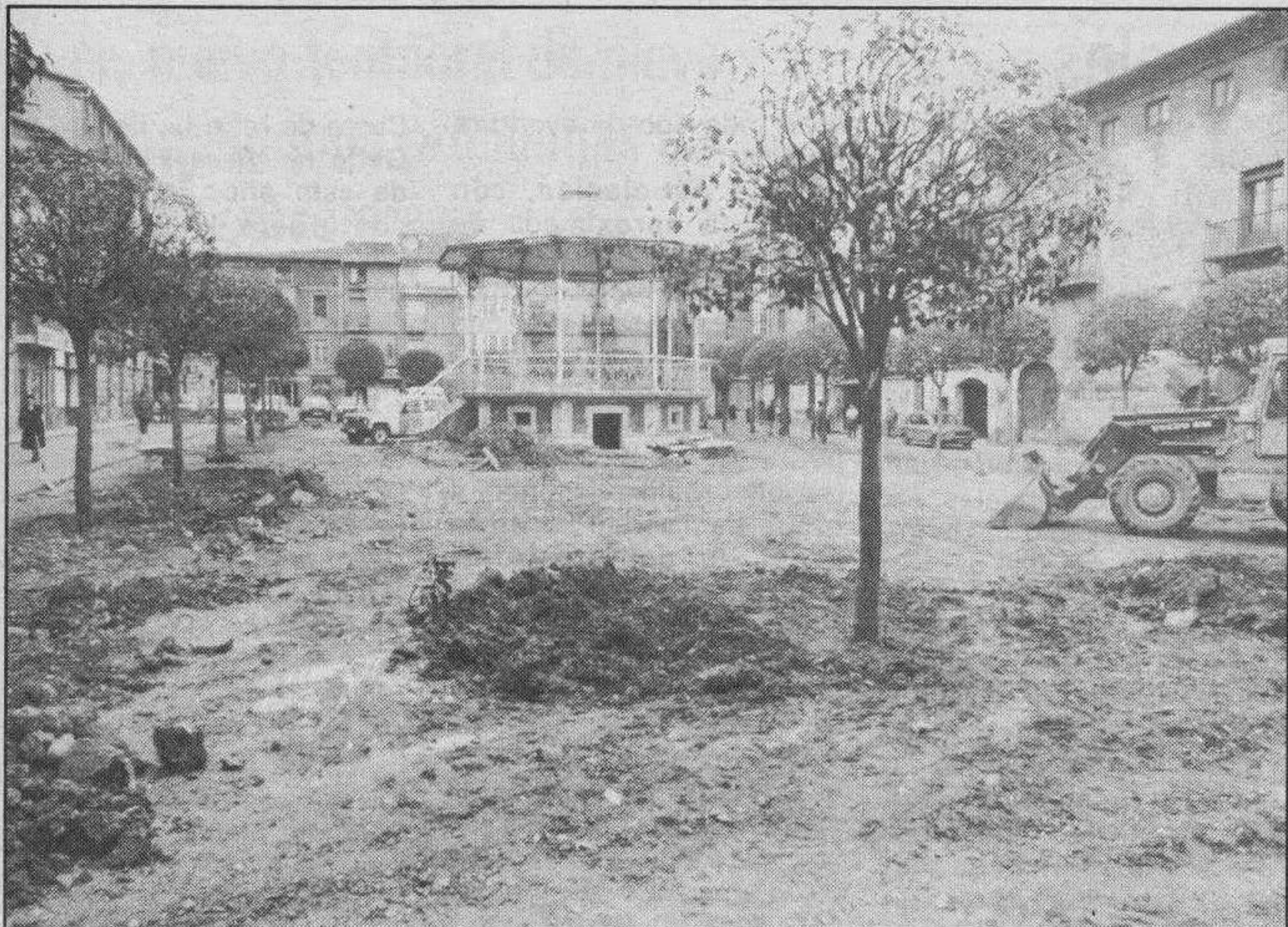
Obras de la Plaza de España. — Foto Truchuelo.
