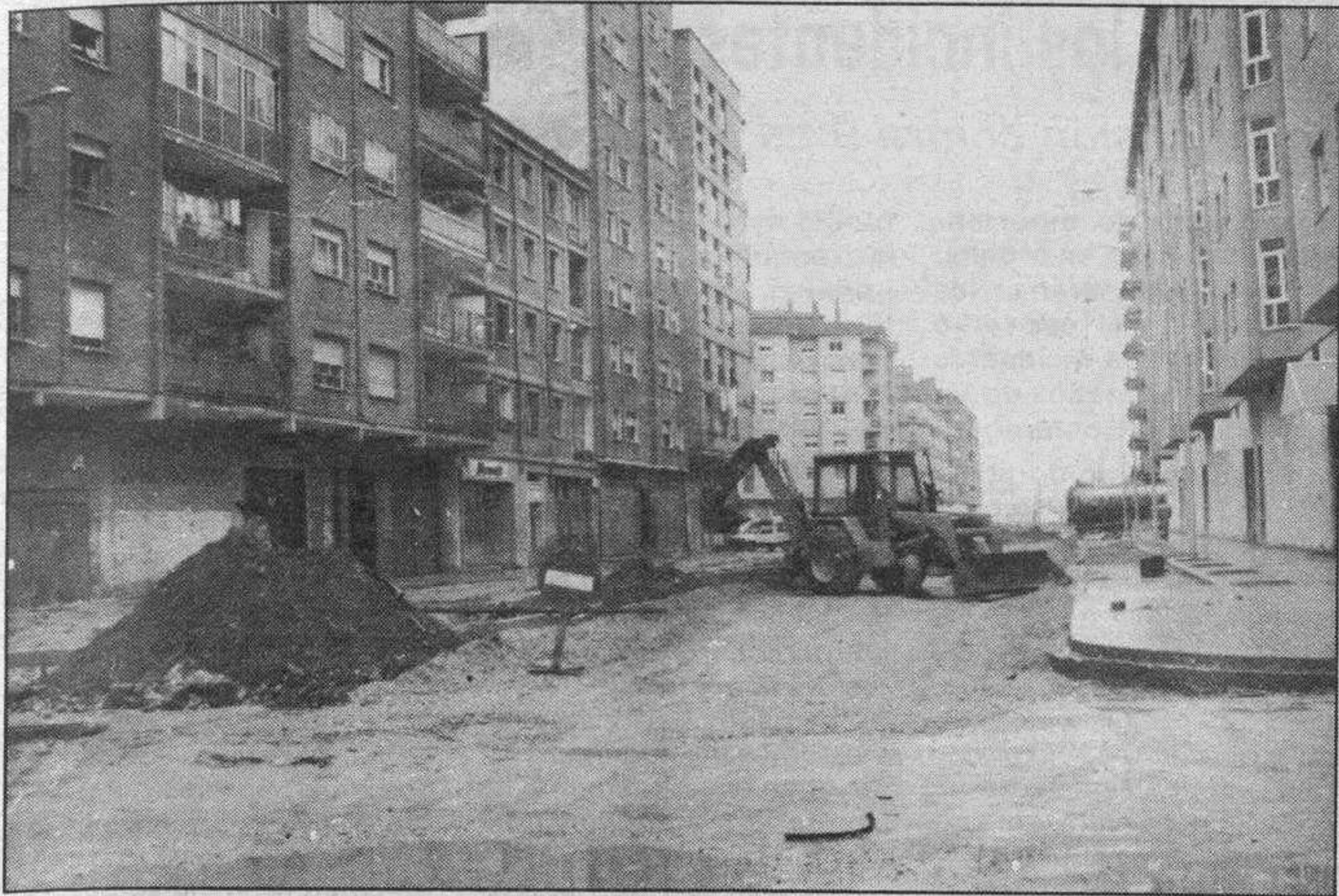
Estado actual de las obras de la Avenida de la República Argentina. Foto Truchuelo.
