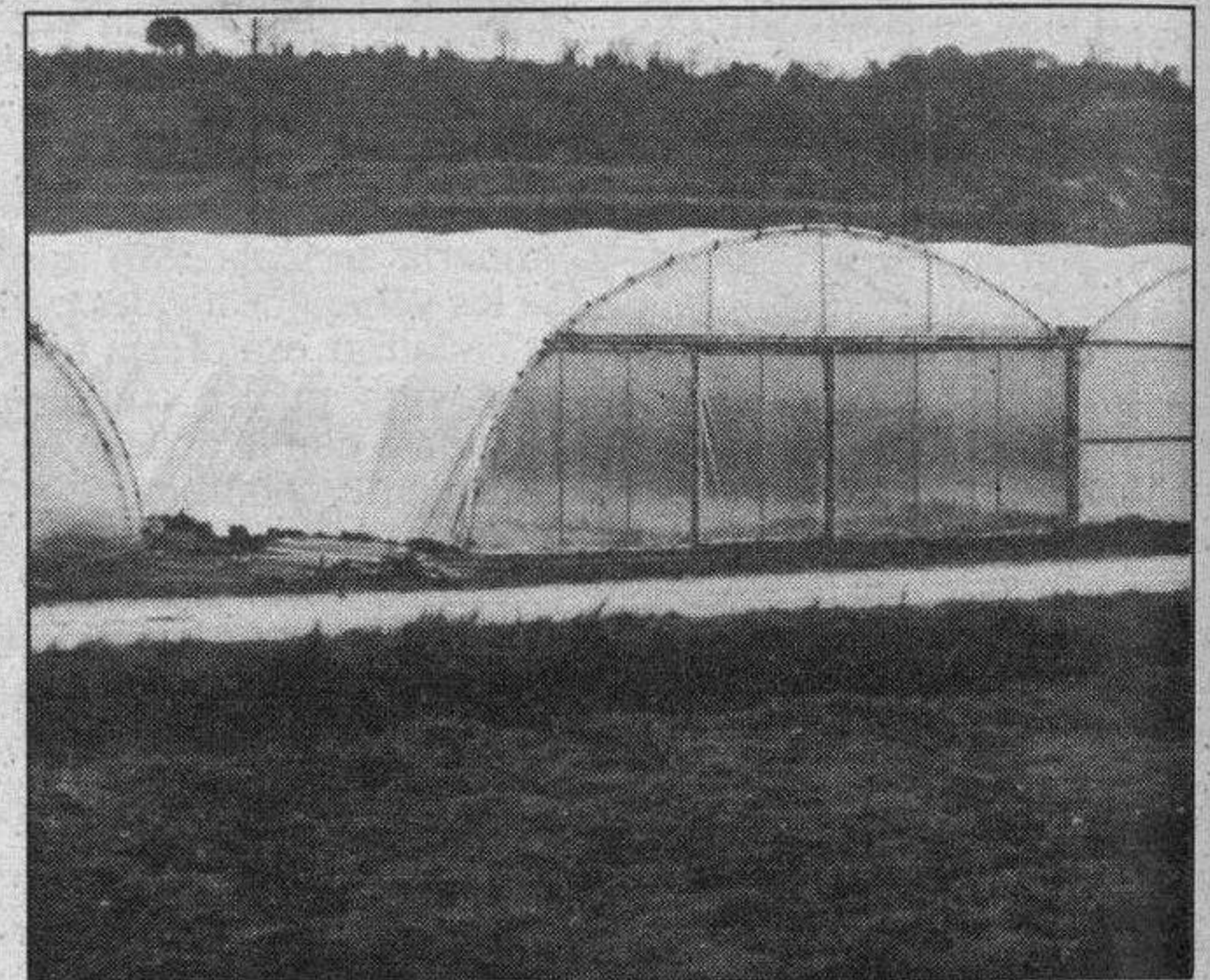
El Gobierno autónomo invertirá 2.000 millones en mejorar estructuras.
