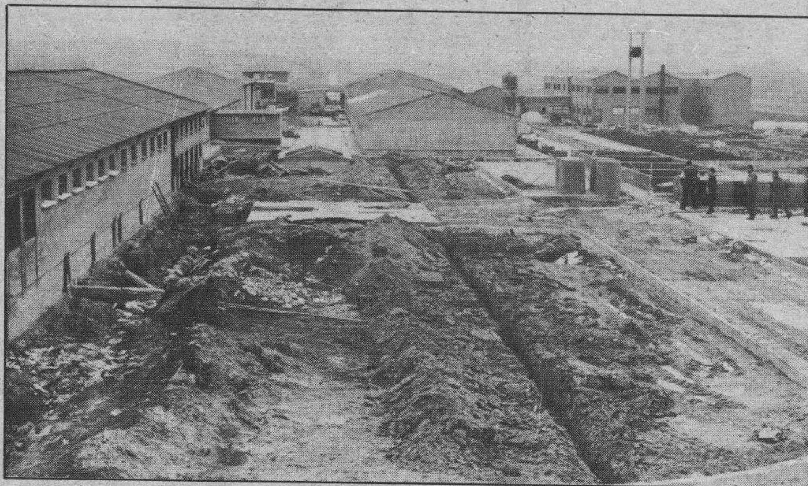
El «complejo de Albillos» en su última fase de construcción
