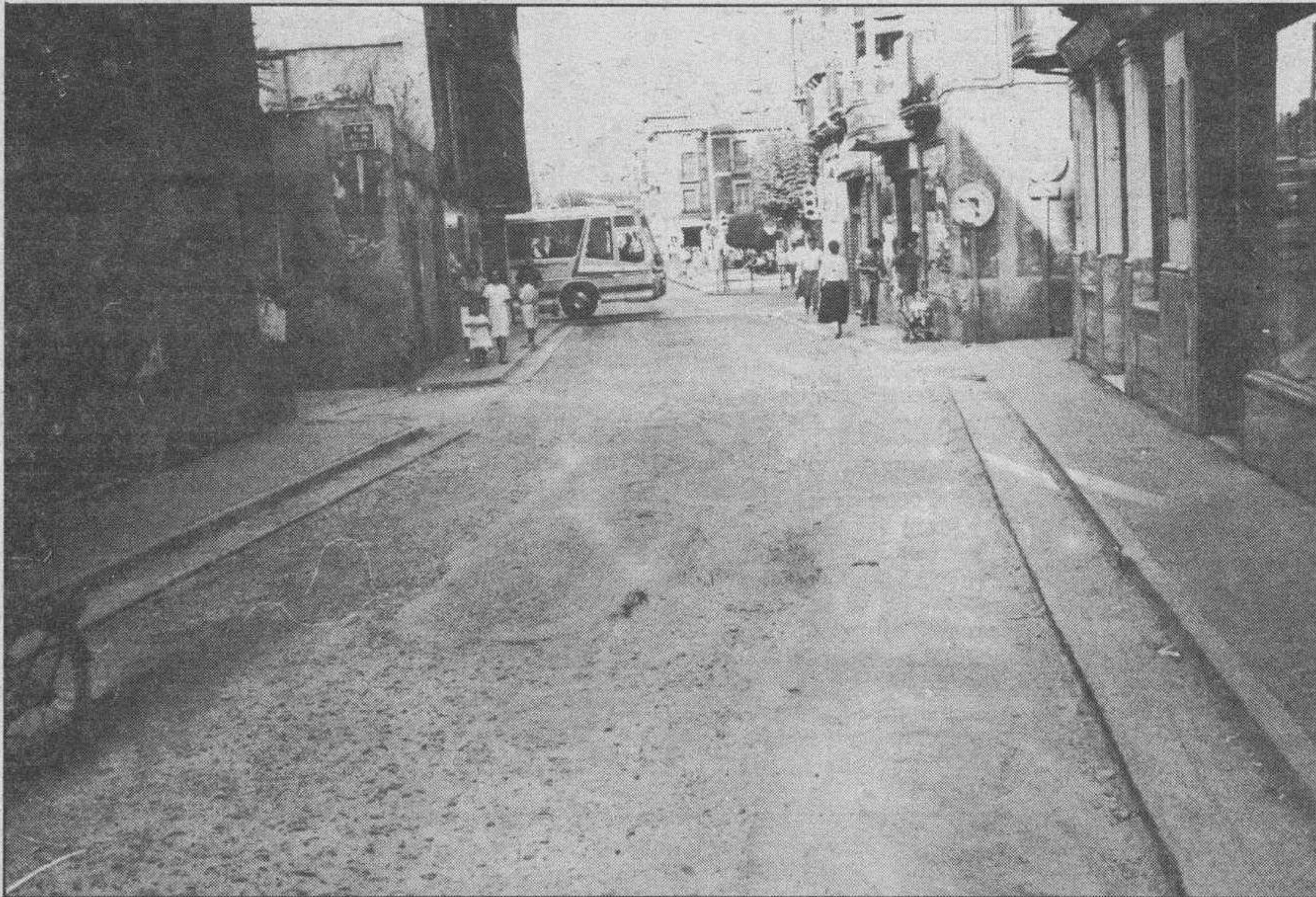
Esta es la calle Real Allende que precisaba unas obras de reparación con urgencia a la vista de su lamentable estado. Los trabajos se han iniciado.
