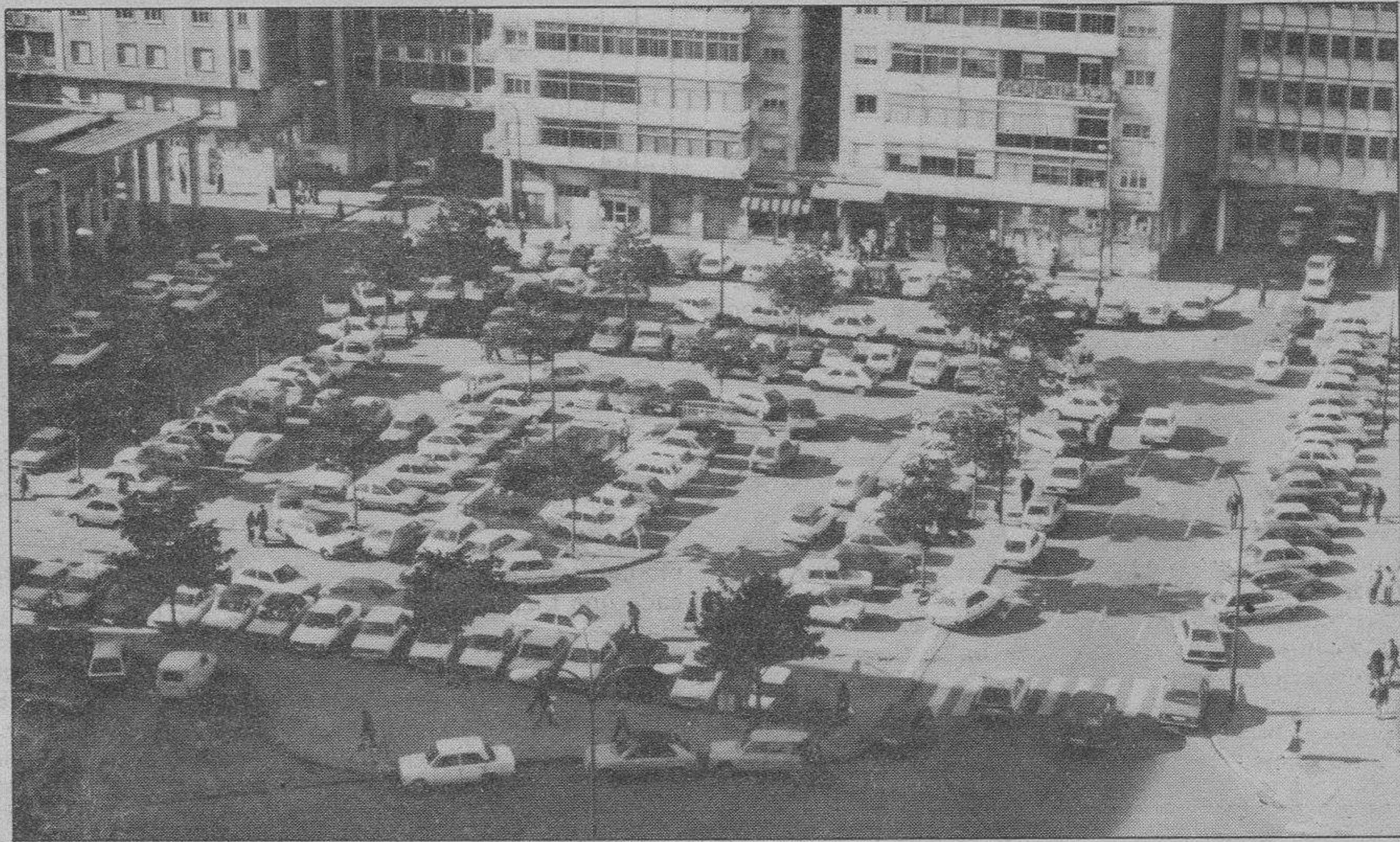
La configuración actual de la Plaza de España sufrirá un cambio de imagen, producto de las obras del aparcamiento que se construirá bajo ella.
