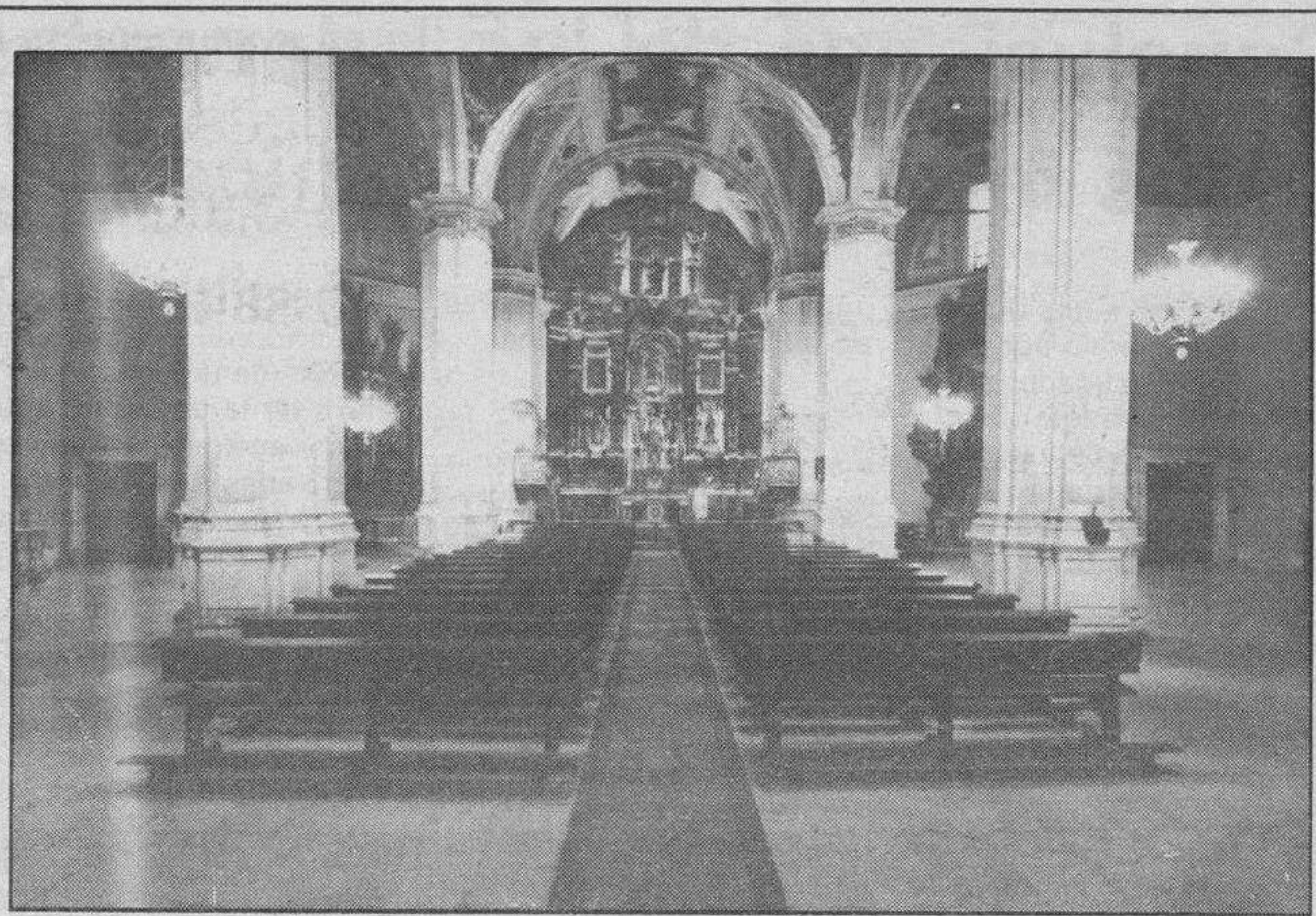
Amplia nave central de la iglesia de San Lorenzo, el Real, que hace años registró obras de mejora y que ahora precisa de urgentes trabajos de restauración, principalmente en su zona de cubiertas.
