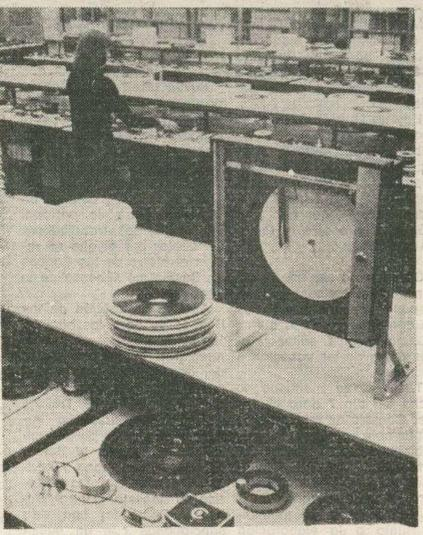
Registrador de humedad y temperatura en una sala de grabación de cintas magnetofónicas. — (Foto EFE).
