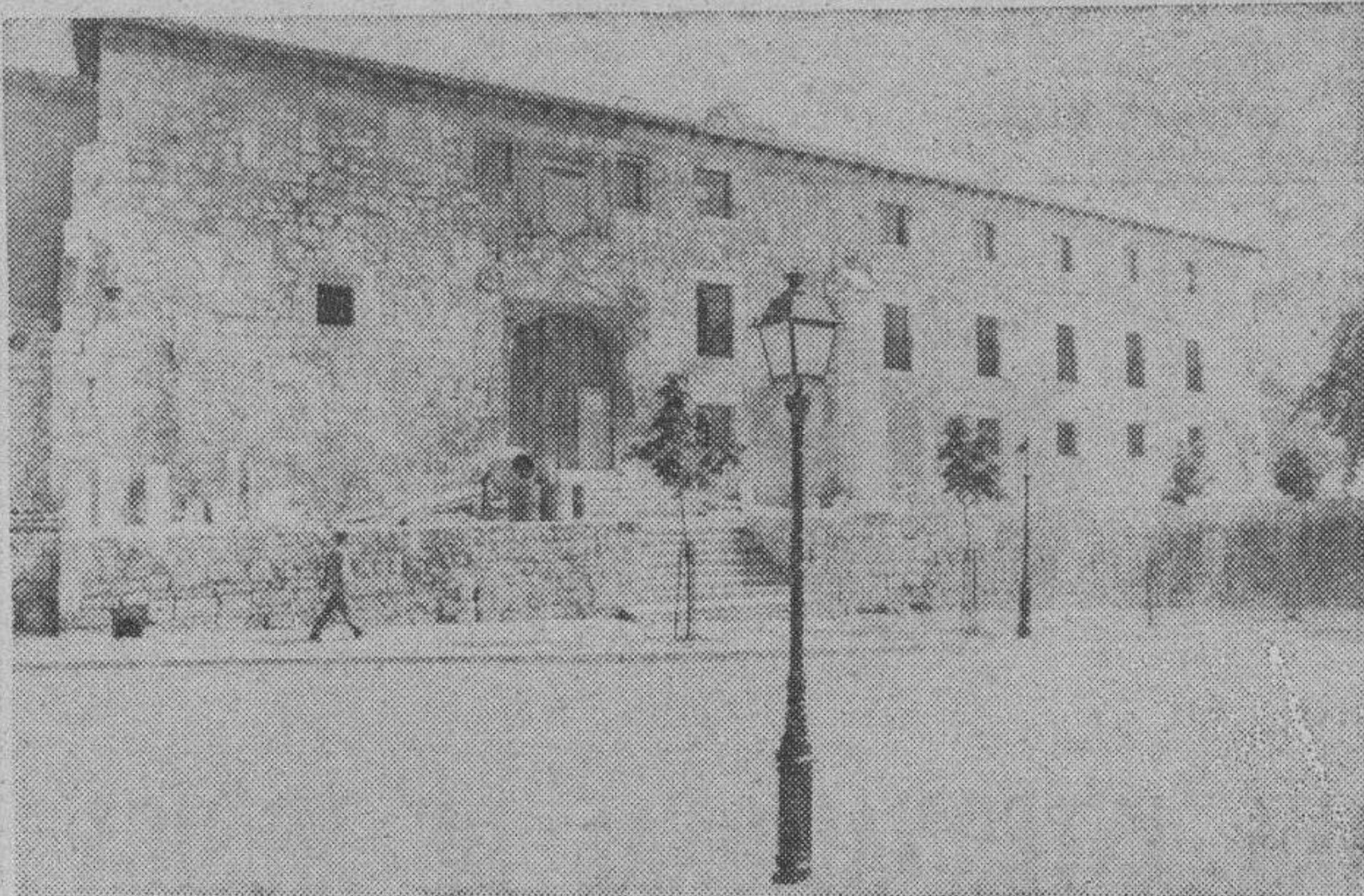
Para mediados de Octubre se quiere inaugurar el Centro Cultural de la antigua Prisión Provincial, que tiene un auditorio de más de quinientas plazas. Los accesos han sido debidamente acondicionados como se puede apreciar en la fotografía. — (Foto FEDE).
