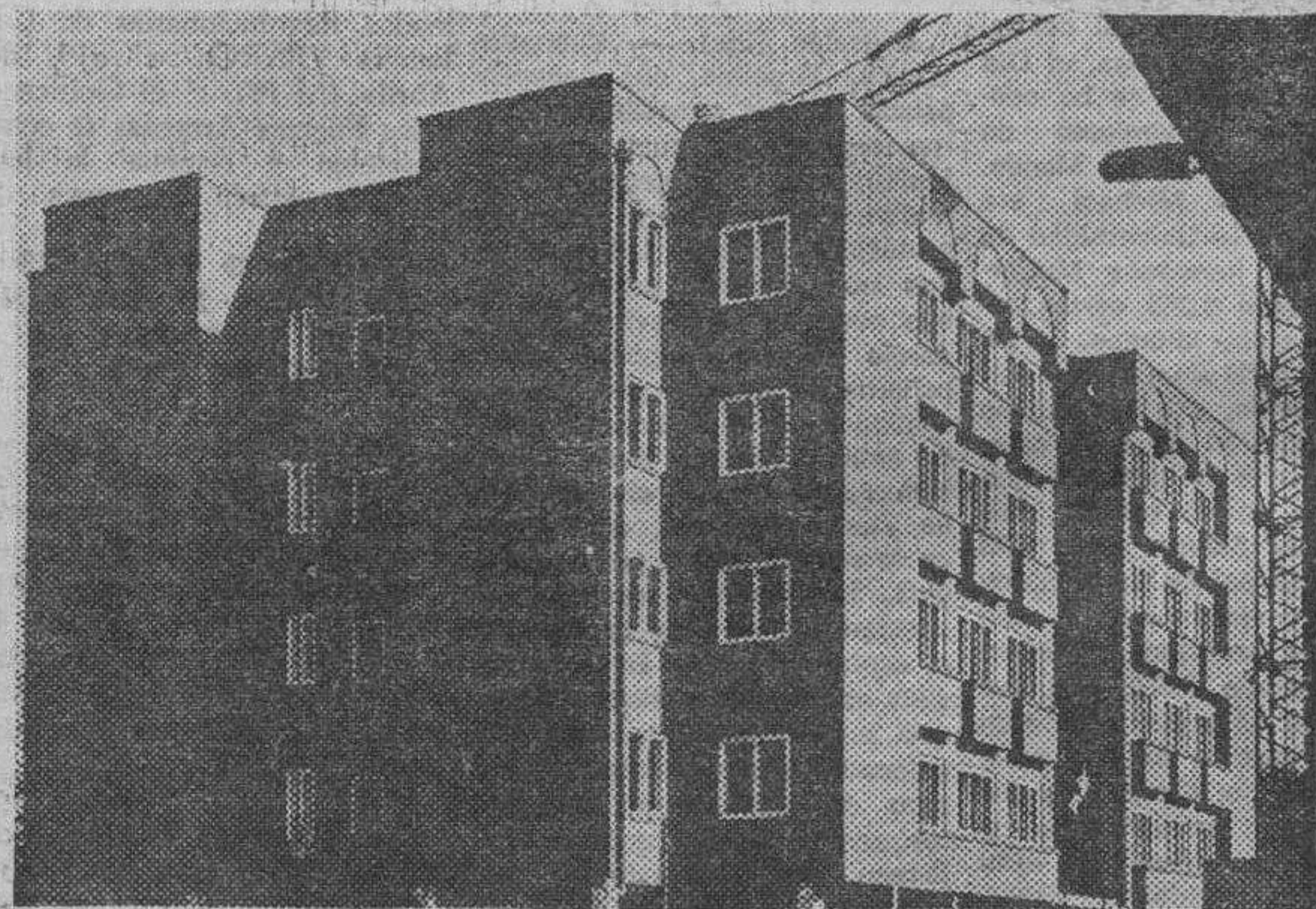
EDIFICIO EN P.ª DE LA QUINTA
