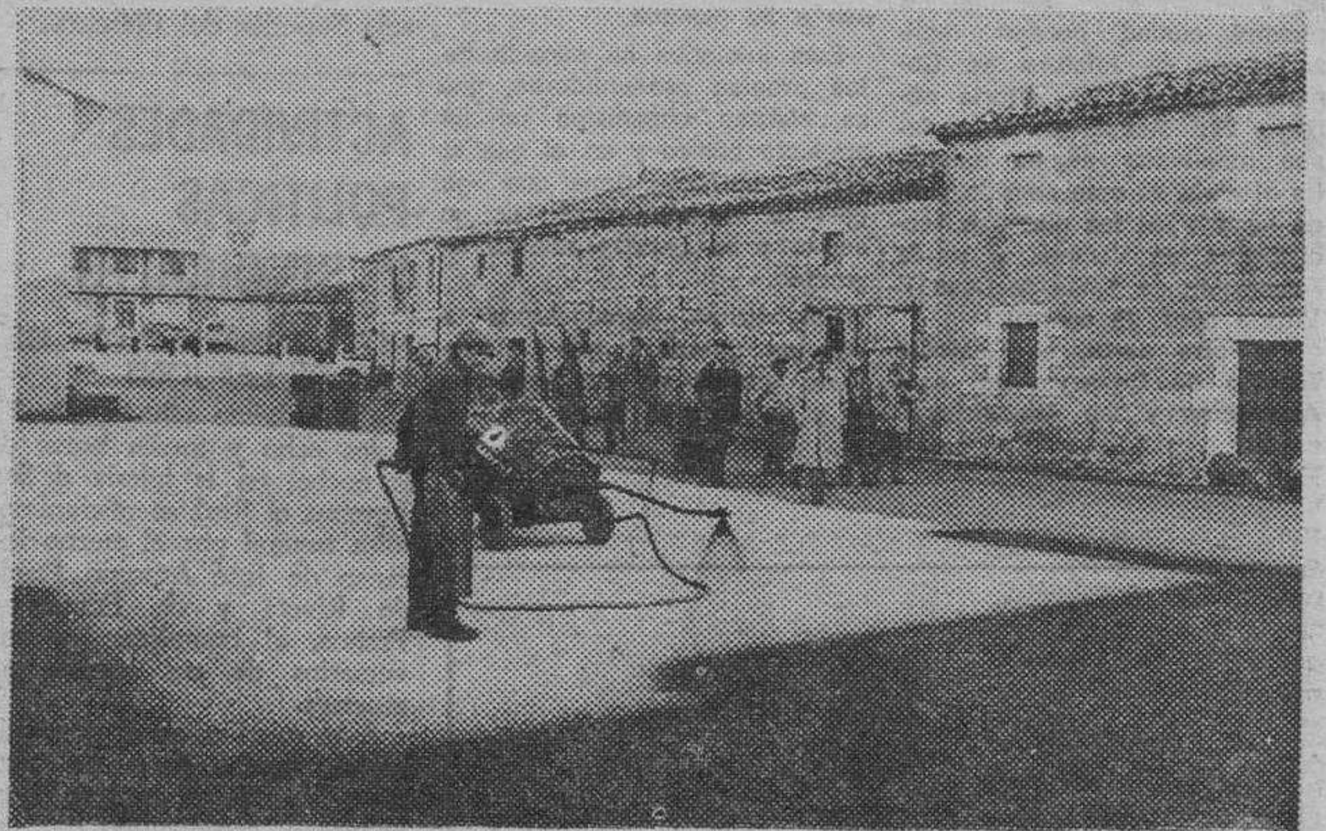
Pedrosa de Río Urbel está a punto de concluir la pavimentación de sus calles con la ayuda de uno de los Equipos Municipales de la Diputación. En el grabado, el presidente de la Corporación presencia los trabajos de riego asfáltico. — (Foto FEDE)
