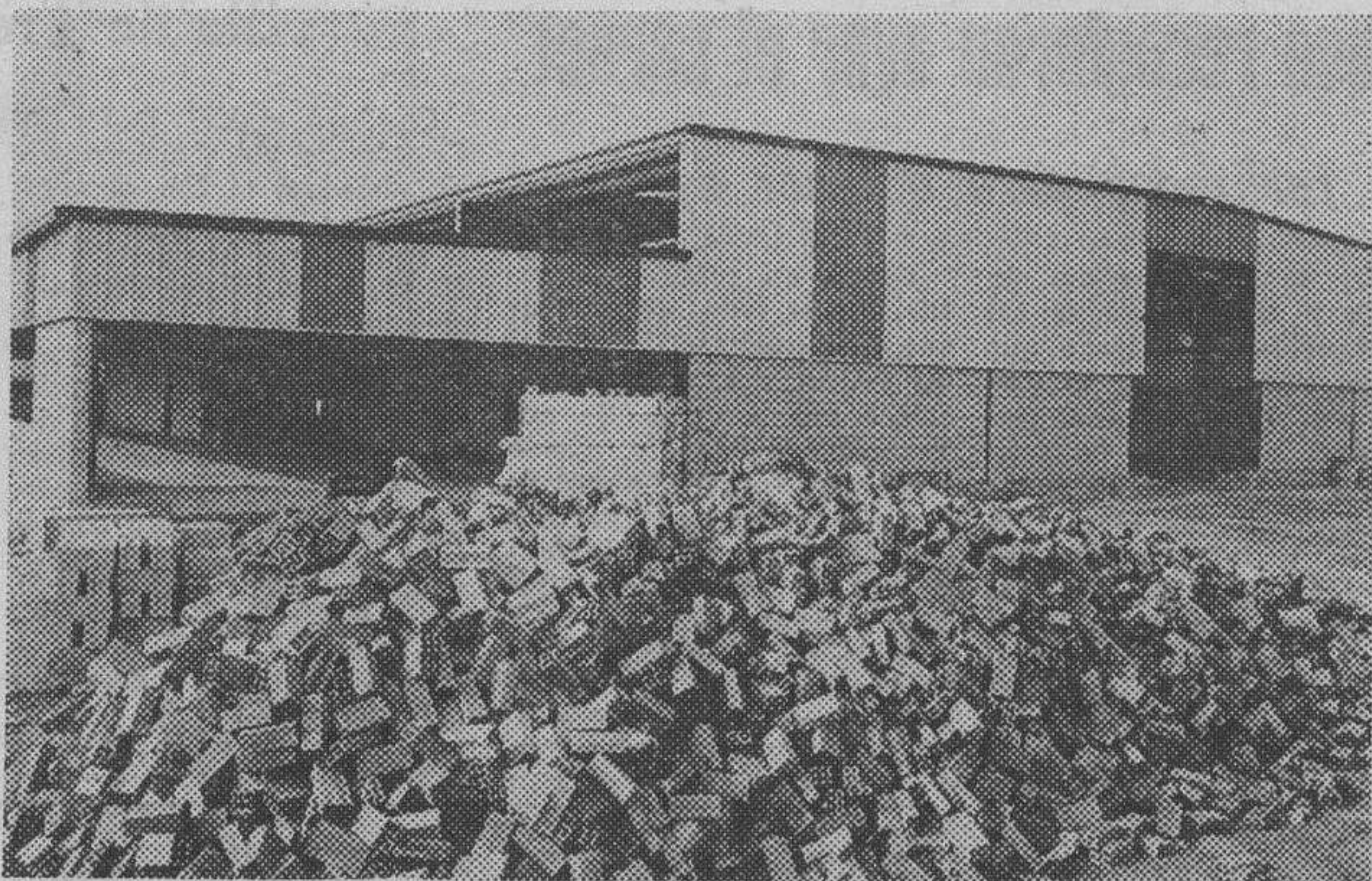
Vista parcial de la construcción de factorías.
