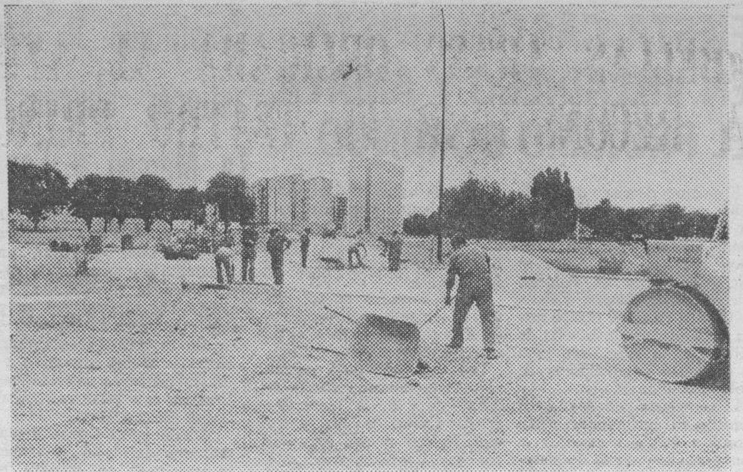
Obras en el Polígono de Carrero Blanco
