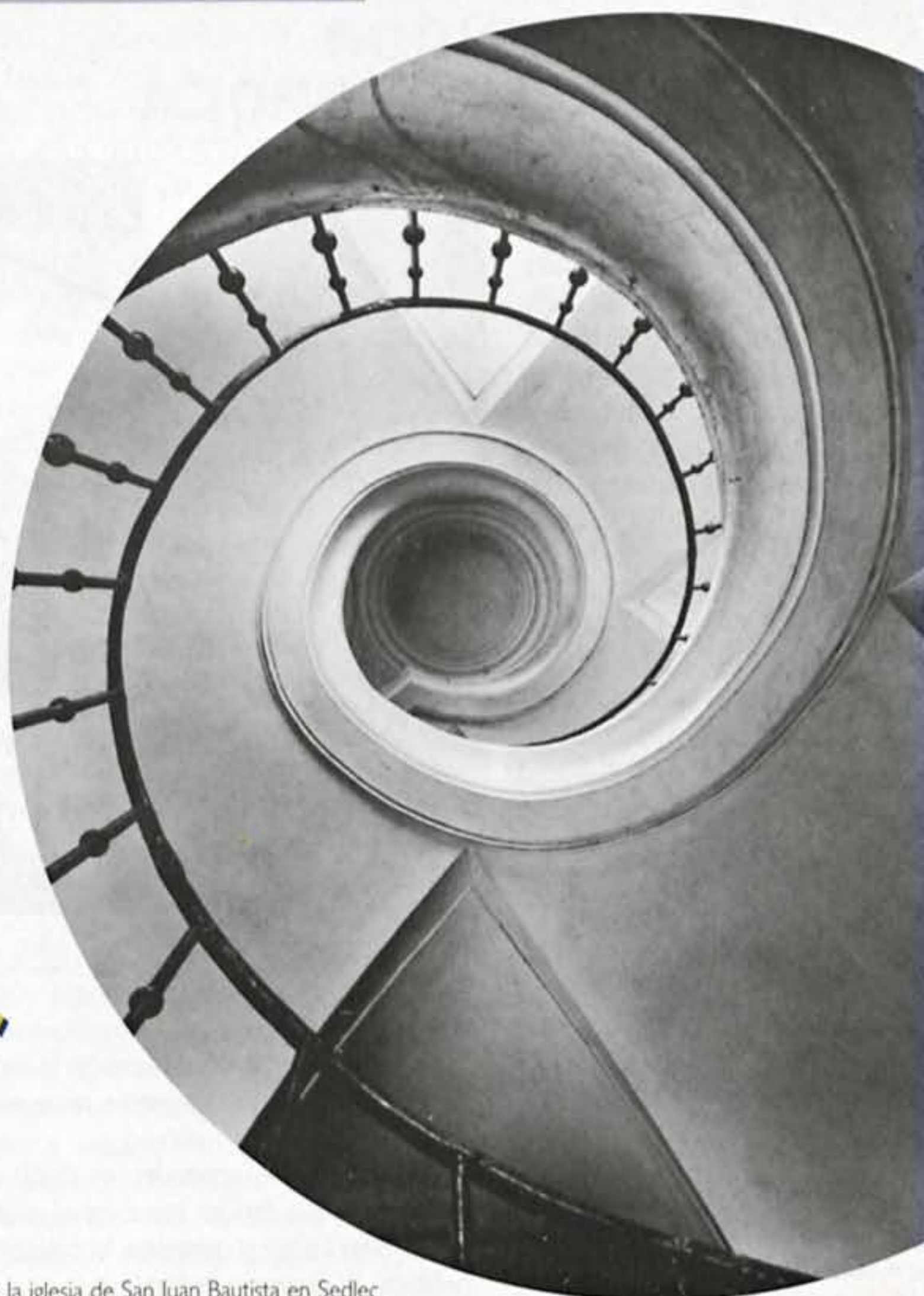
Escalera de la iglesia de San Juan Bautista en Sedlec Obra de Jan Blazej Santini-Aichel, 1703-1709.
