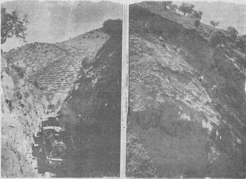
A la izquierda: Trinchera K-76.900, con los dos trenes de trabajos de desescombro. — A la derecha: Detalle del desprendimiento
