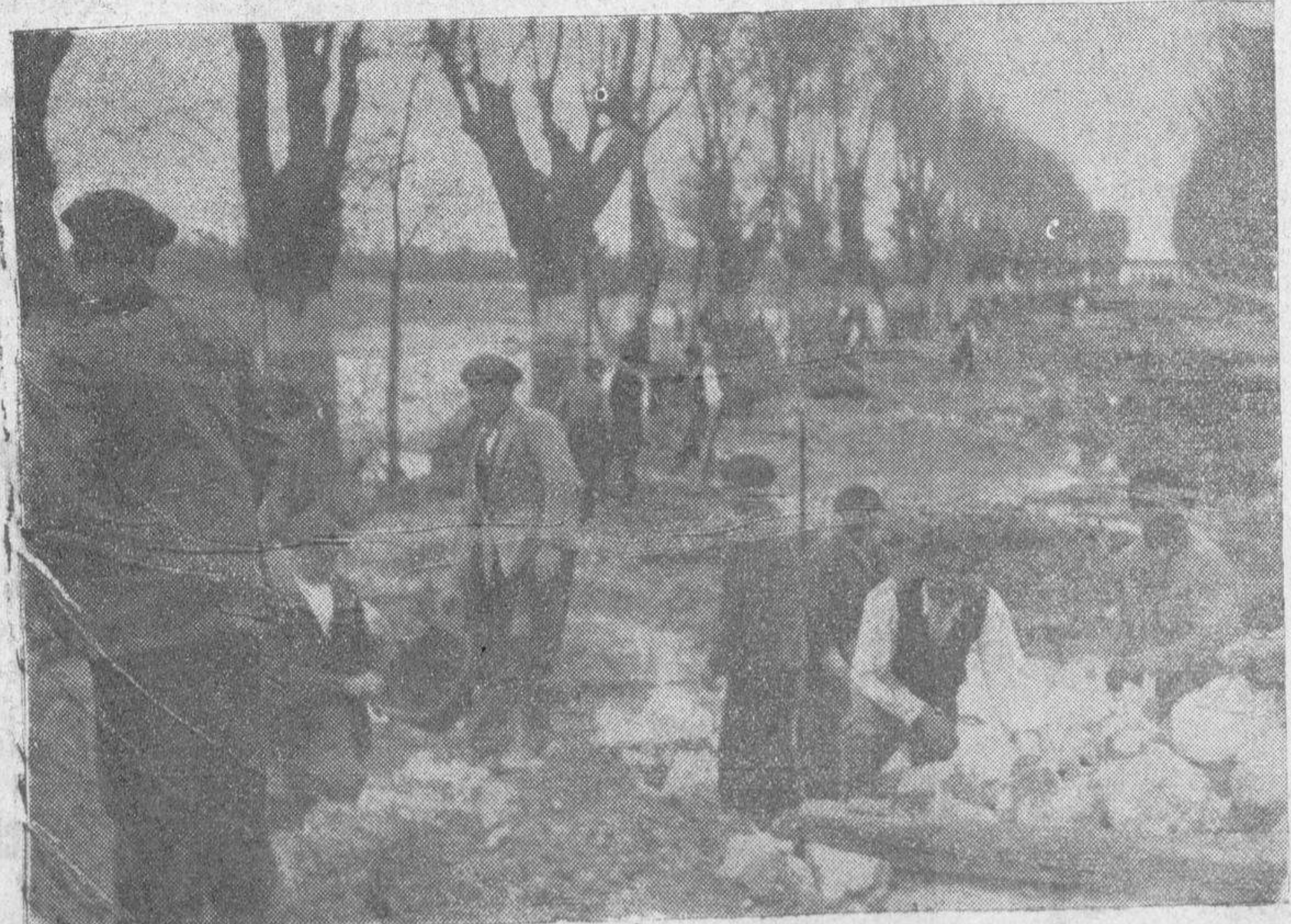
Estado en que el temporal de lluvias ha dejado la carretera de Madrid, en las inmediaciones del puente de Encinas, cuyas obras de arreglo se están efectuando
