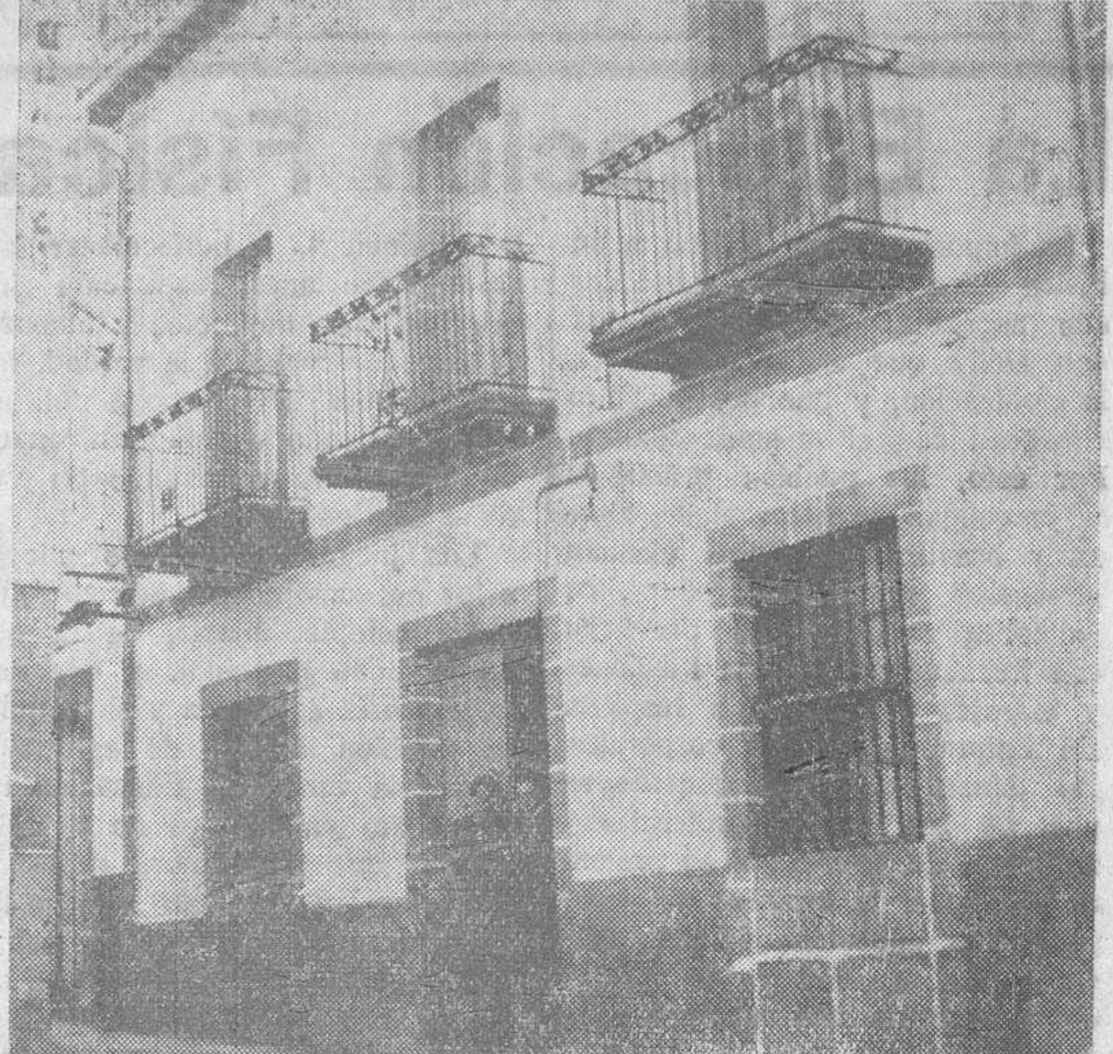
Edificio donde está establecido el Centro secundario de Higiene rural de Béjar
