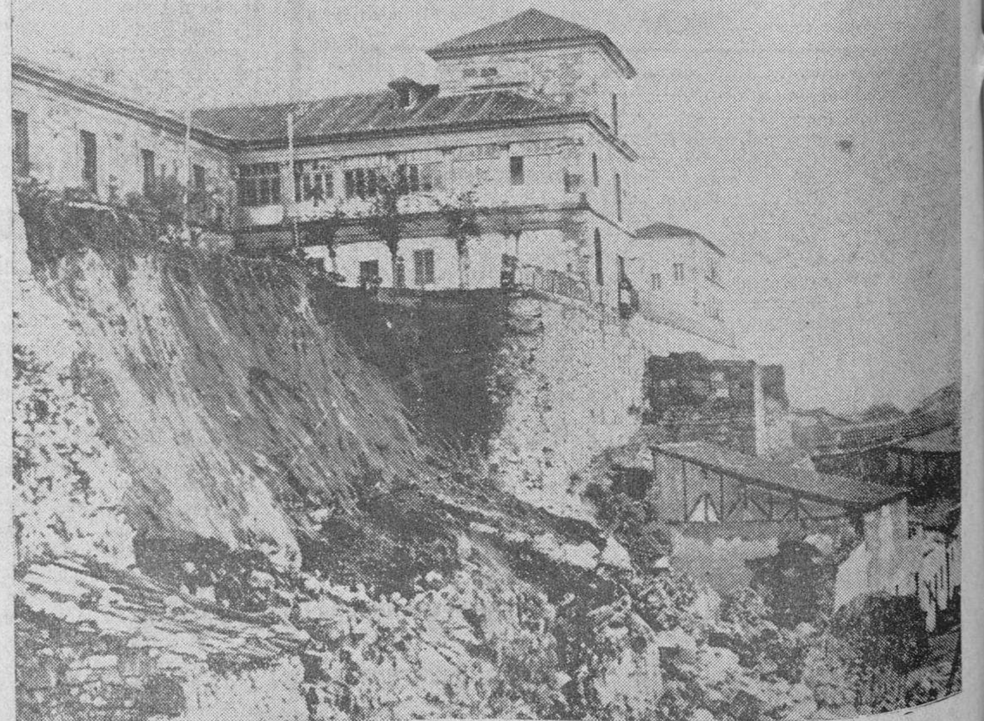
Como se temía, el viernes se derrumbó el muro de «Los Caídos», ocasionando el aplastamiento de dos casas de la antigua calle de San Gregorio, según damos cuenta en nuestro último número. He aquí una demostración gráfica de la importancia del accidente y de los caracteres trágicos que pudiera haber revestido, de no haberse adoptado por las autoridades medidas preventivas. -Foto Almaraz
