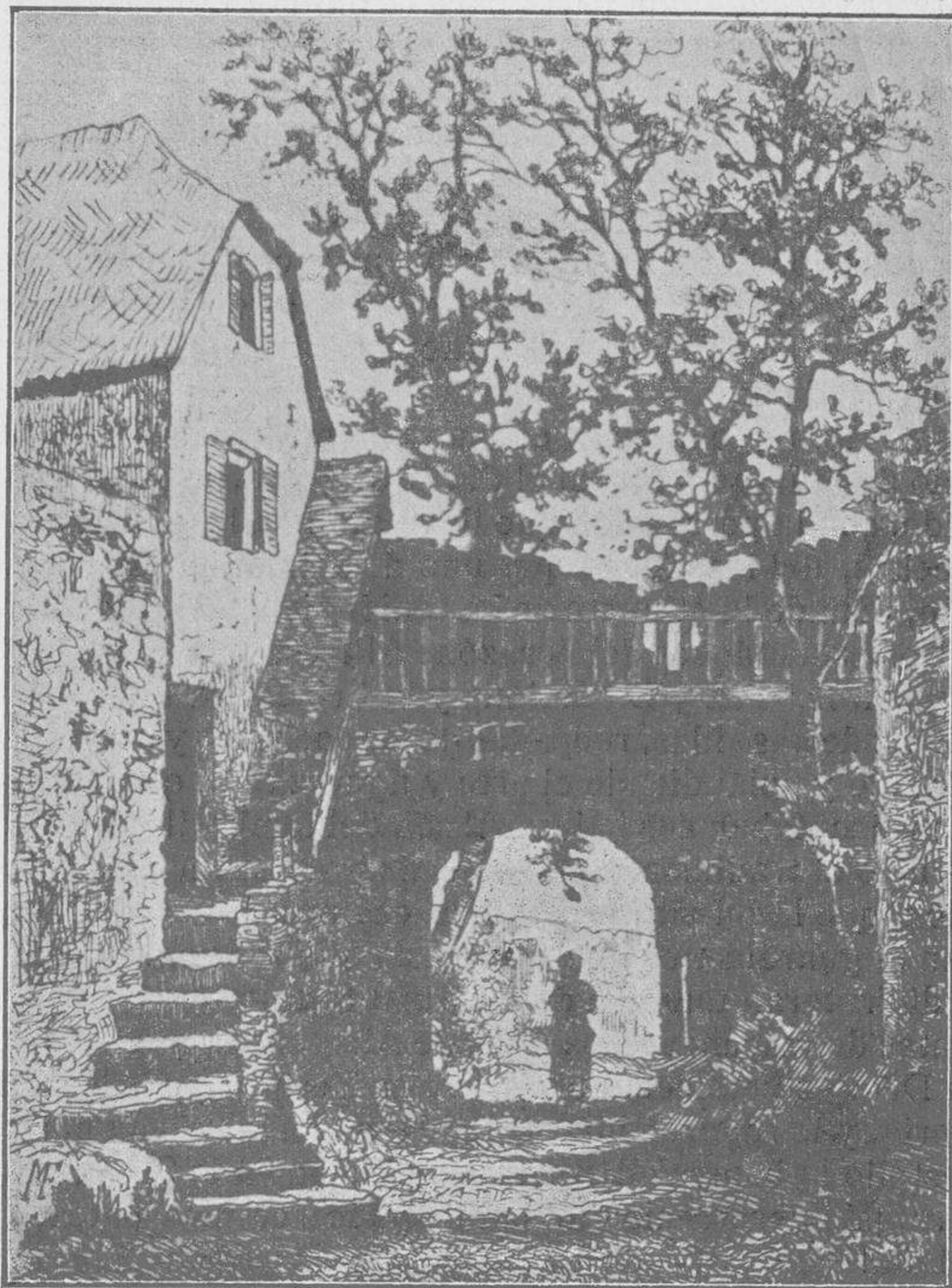
PUENTE EN VILLERS (BELGIQUE)
