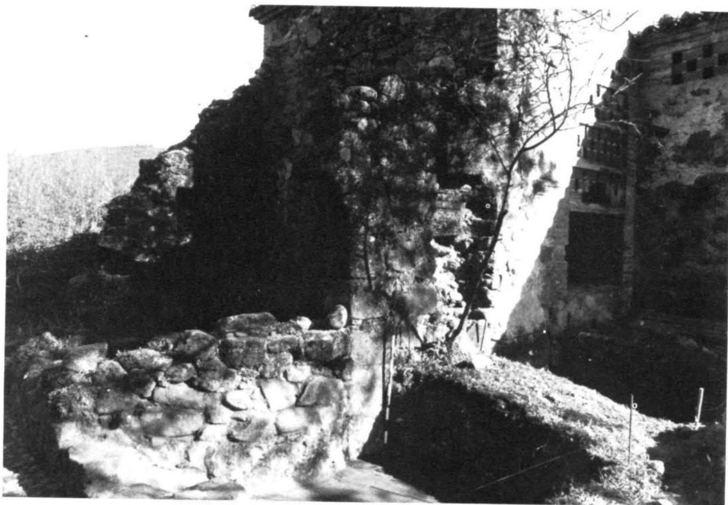
1.—Catas 3 y 6. Nivel de tierra vegetal y escombros hasta embaldosado.
