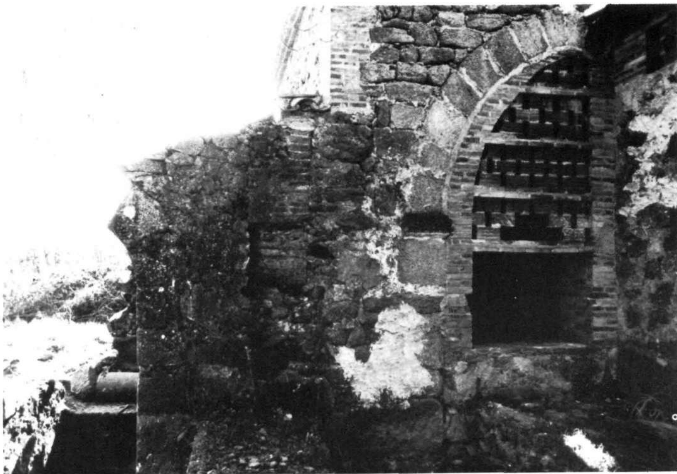
1.—Arcos de acceso a las dependencias I y II.
