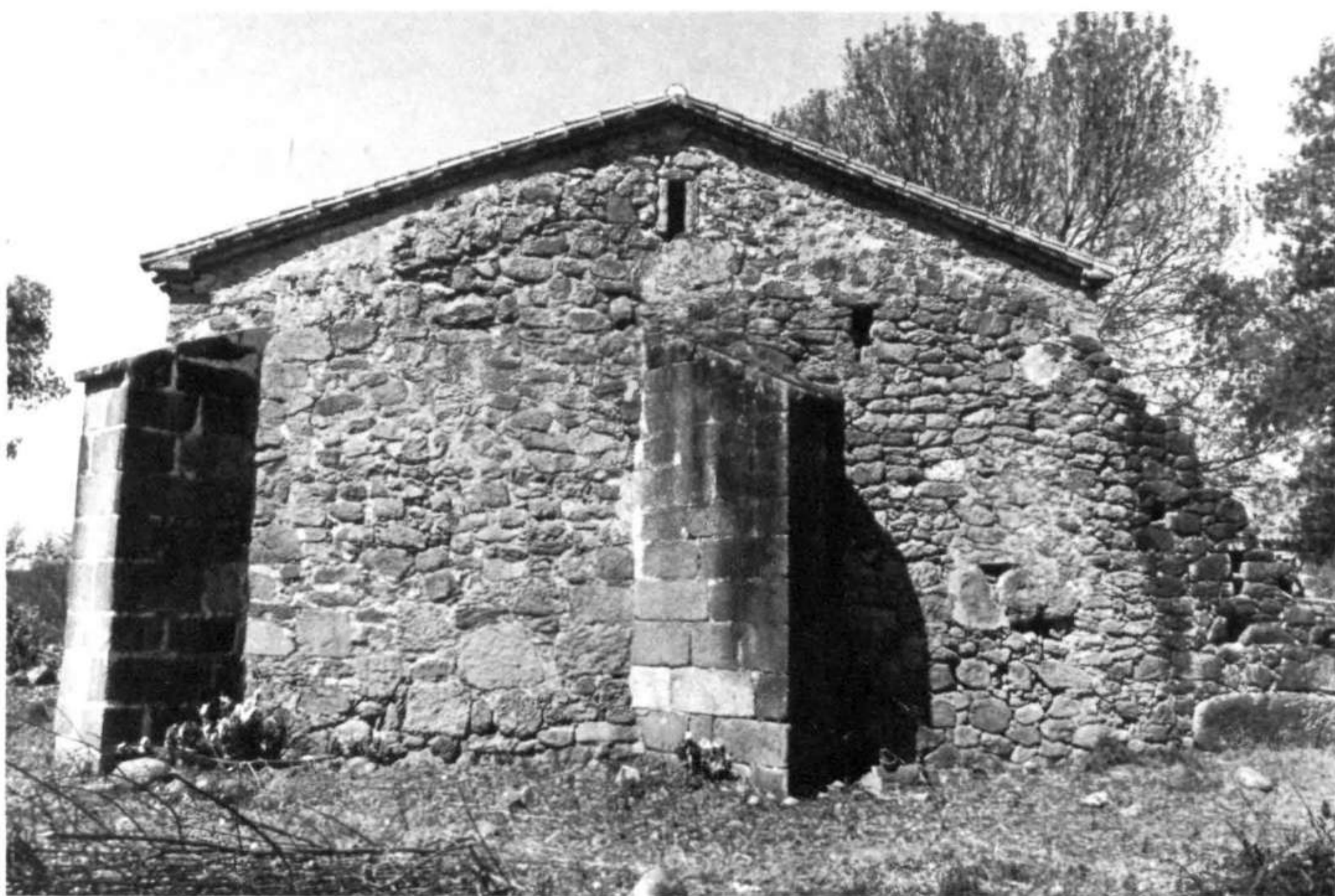
2.—Muro de la cabecera de la ermita.
