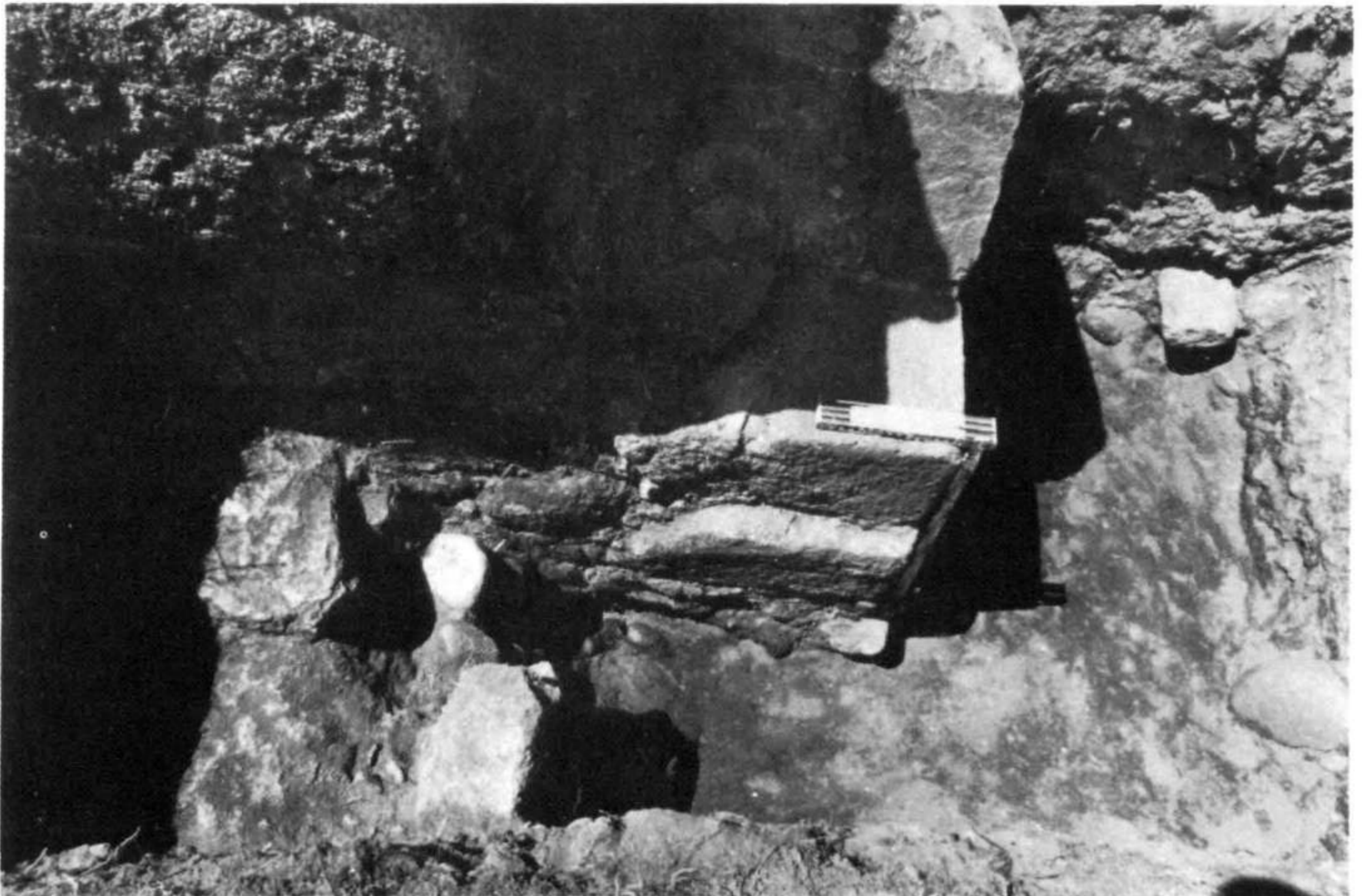
2.—Cata 18. Sillares de los cimientos de la esquina NE. del muro de la cabecera.
