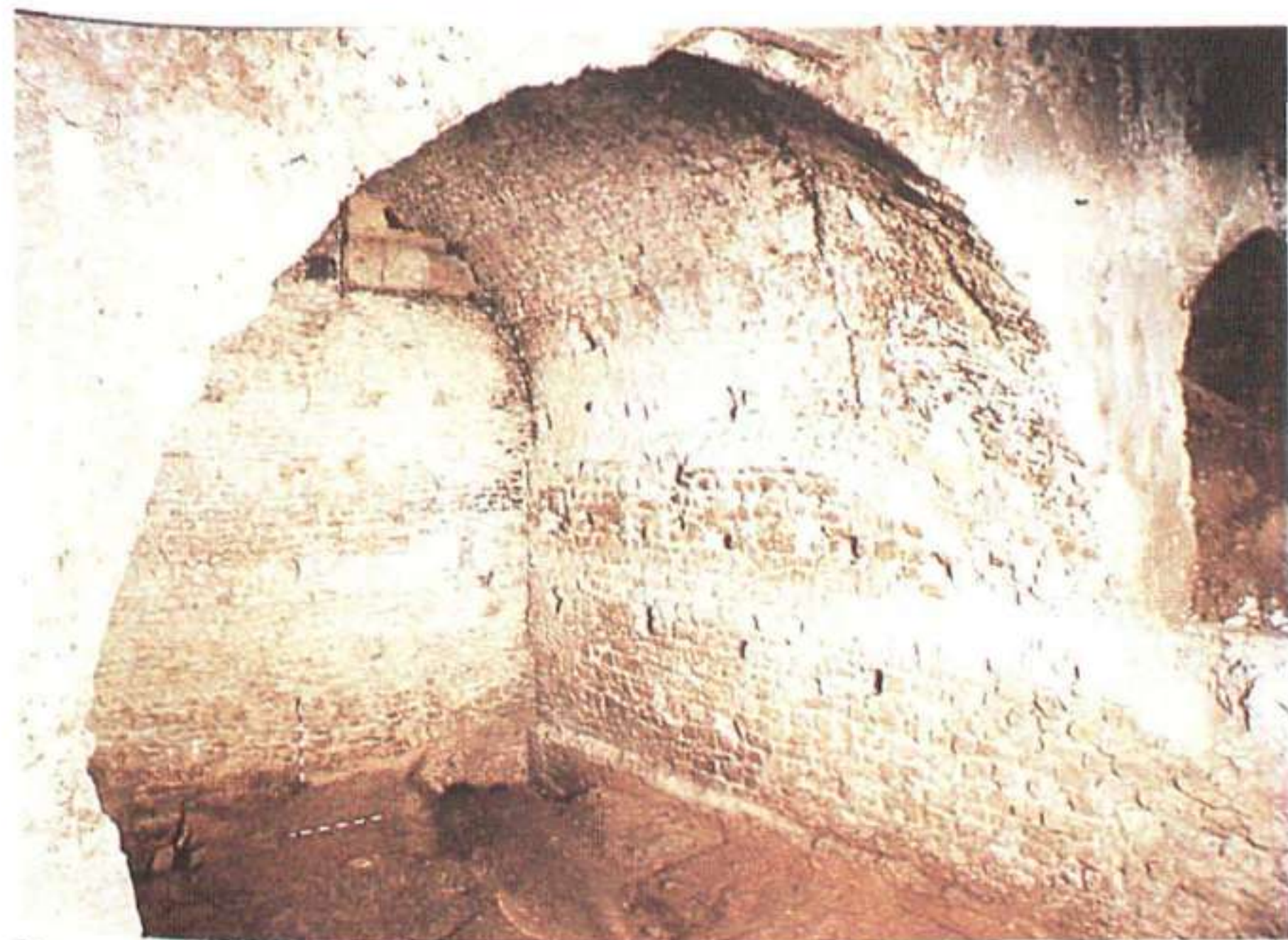
Bóveda del sector central del graderío norte del circo romano de Tarragona.
