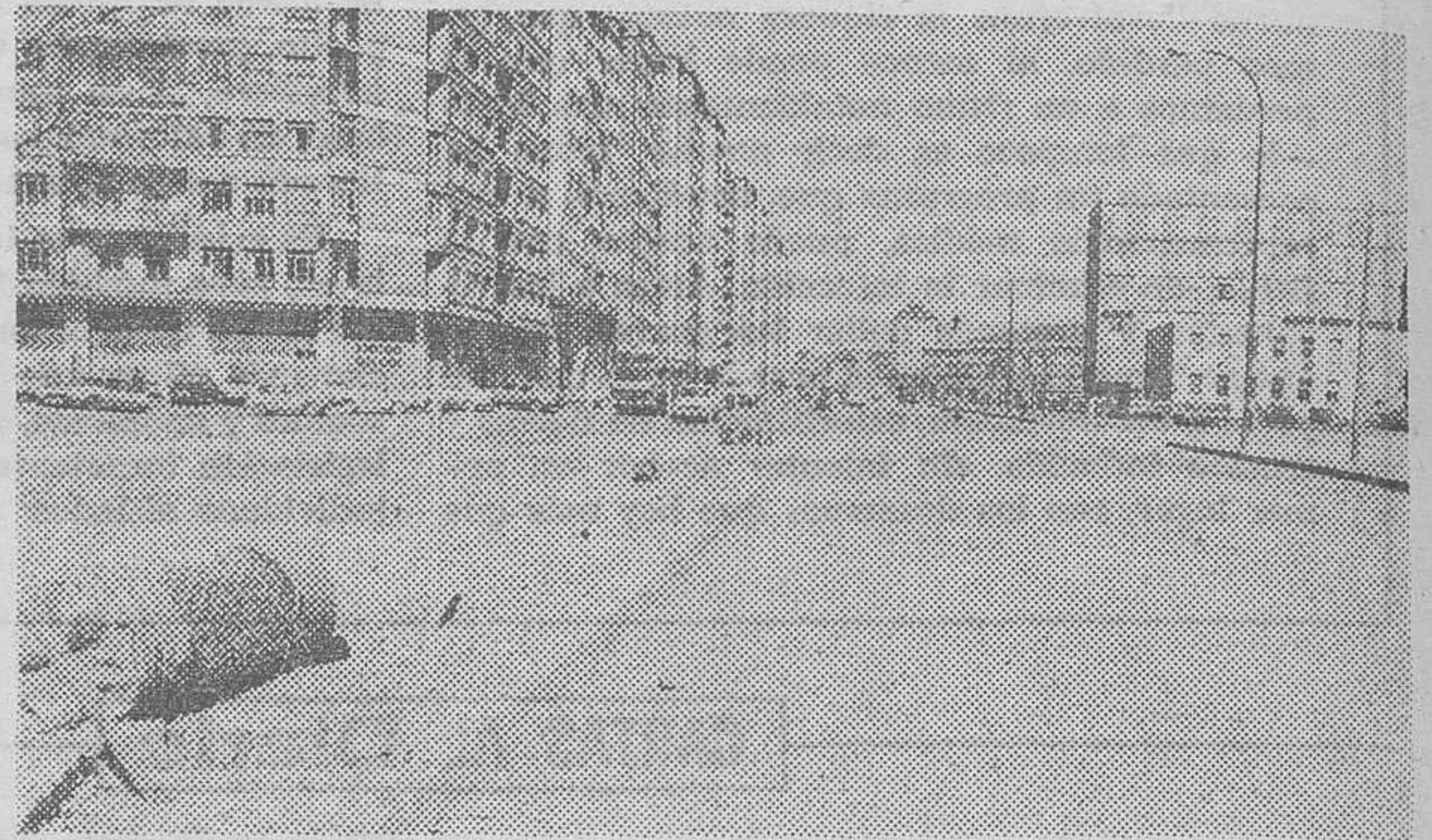
Se ha depositado el material necesario para colocar cortapasos en la avenida de Vigón, según acuerdo adoptado por el Ayuntamiento. Irán en la mediana con el fin de evitar que se atravesara la calzada por aquellas zonas donde no haya pasos de peatones. (Foto FEDE)
