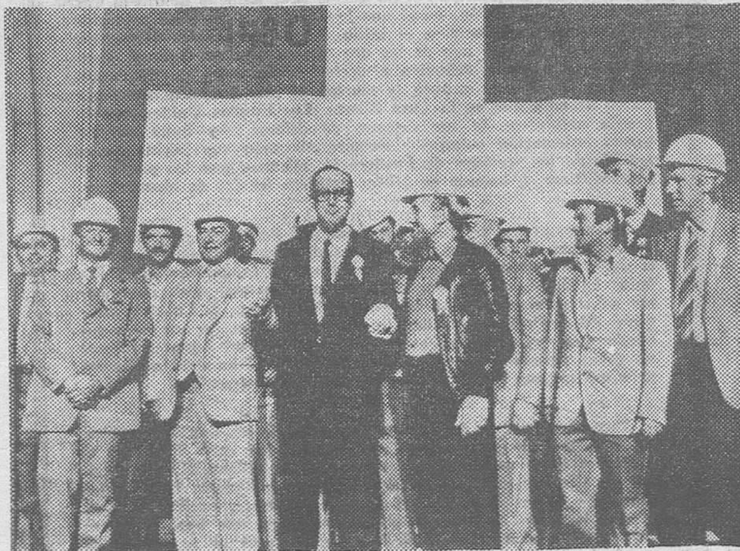
Berna (Suiza). — Fue inaugurado el túnel «San Gotardo», el más largo del mundo, tras diez años de intensos trabajos. El túnel tiene 17 kilómetros de largo y su costo ha sido de 700 millones de francos. En la foto, el ministro federal suizo del Interior, Hans Huerlimann (centro), posa junto a veinte de las personas que trabajaron en la realización del túnel. — (Telefoto EFE-UPD).
