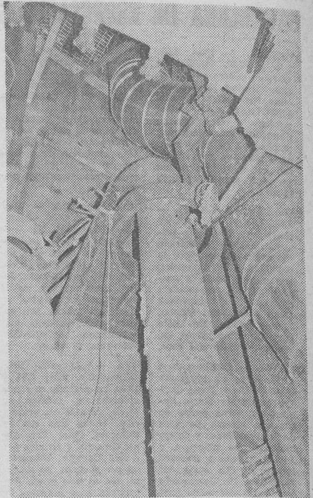
Tubería, dentro de la primera protección del núcleo, donde se ha producido la avería. La fisura originó una fuga de agua que, al elevar el nivel del pozo del vaso, permitió detectarla. — (Foto FEDE)
